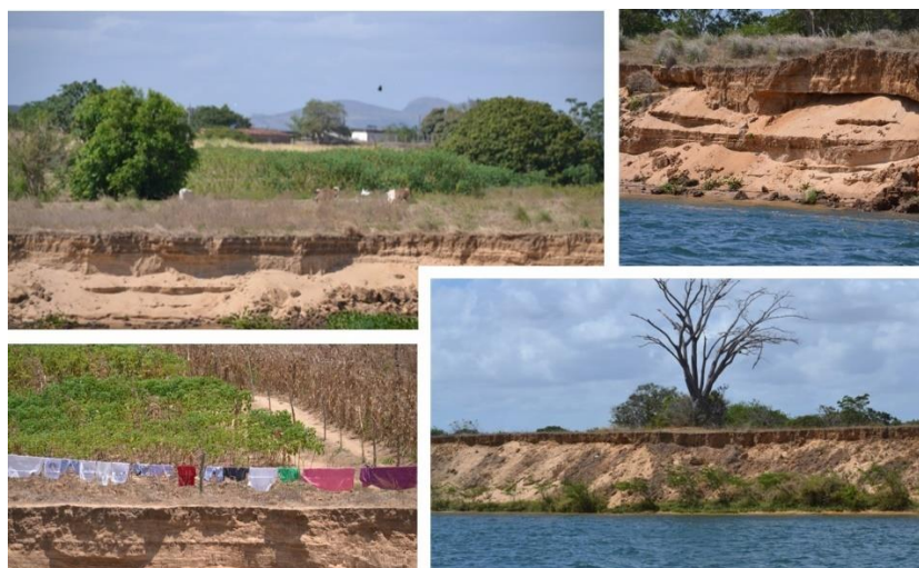
Figura 1. Assoreamento das margens do rio. Foto: Vanildo S. Oliveira
