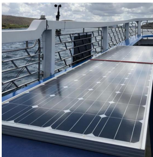
Figura 3. Ambiente experimental para medição dos parâmetros elétrico de gerador fotovoltaico.
