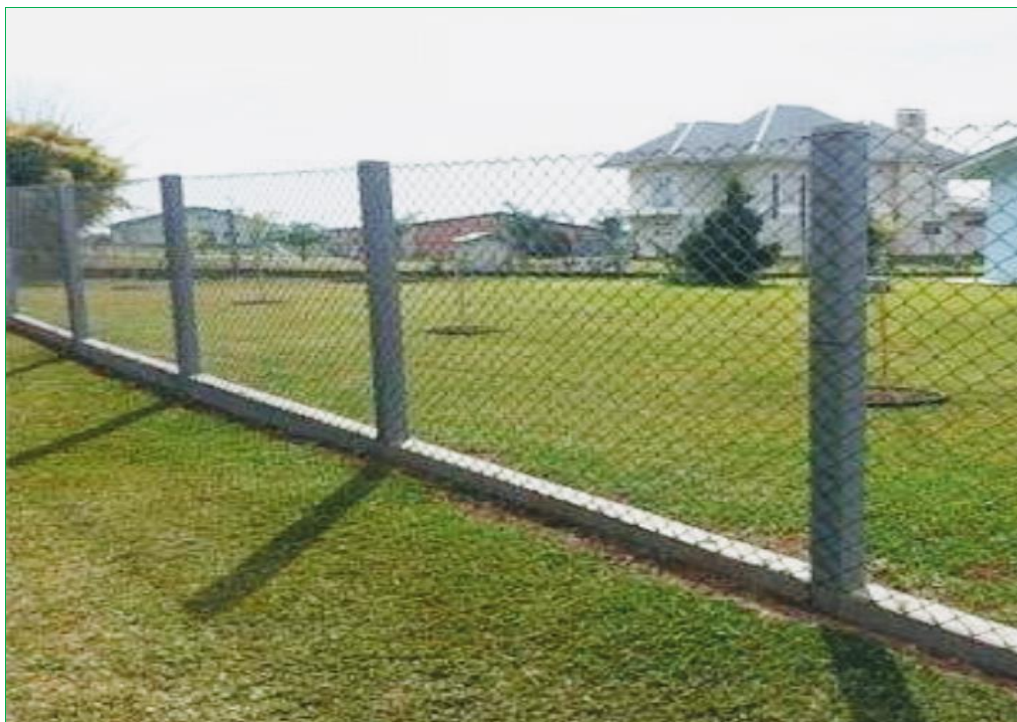
Figura 7.3 – Modelo de cercamento com mourão de concreto e tela.
