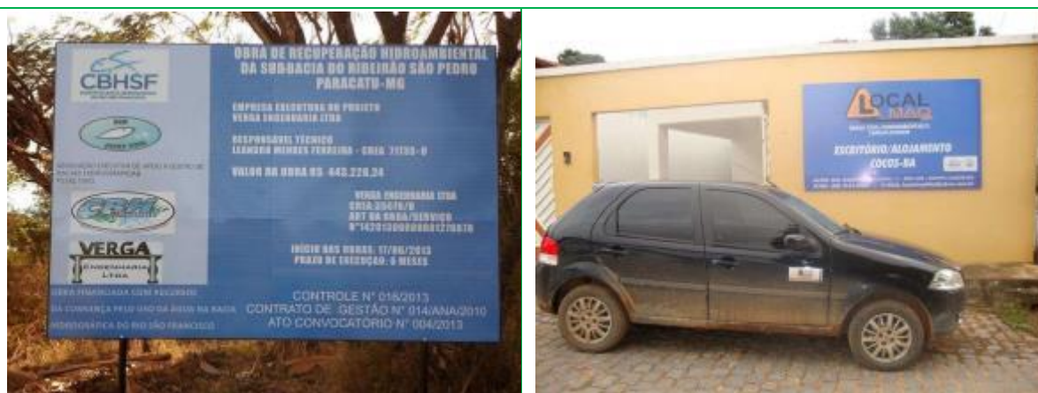
Figura 7.1 – Placa da Obra e Canteiro/Escritório de obras hidroambientais contratadas pela Agência Peixe Vivo.
