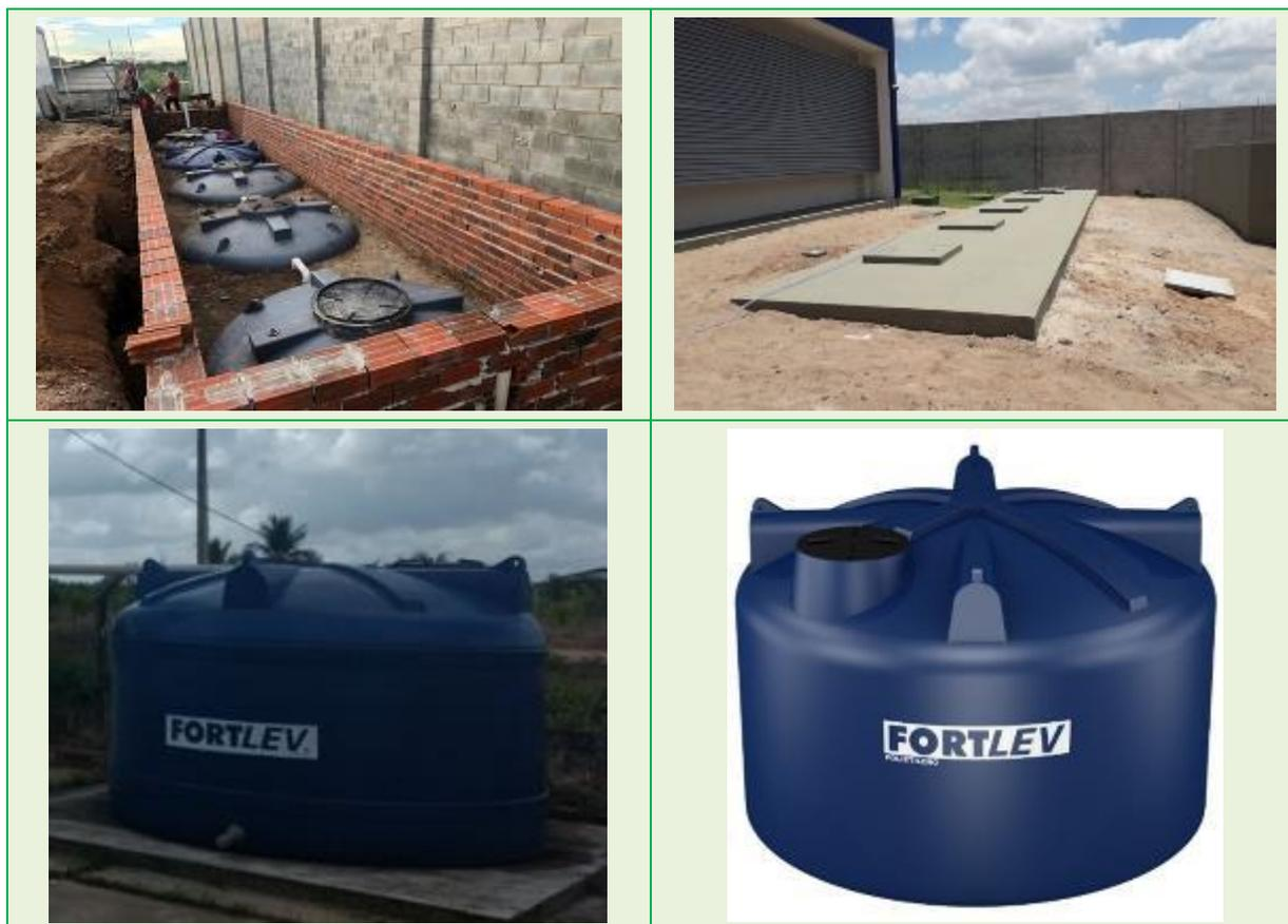
**Figura 12 - Exemplo do esquema da instalação dos reservatórios e modelo de reservatório sugerido.**
