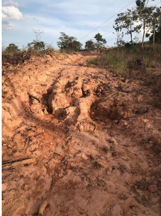
Figura 19: Sulcos erosivos em acesso antigo.
