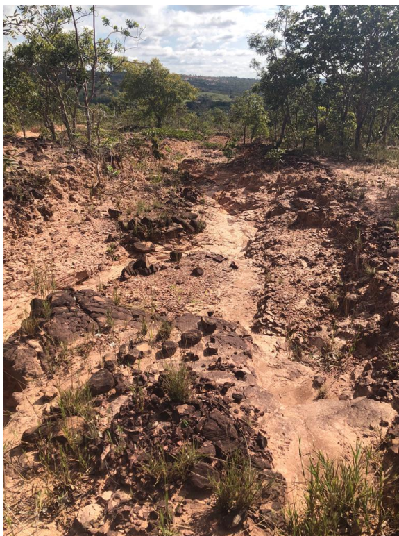
Figura 21: Ravina no Lote 16.
