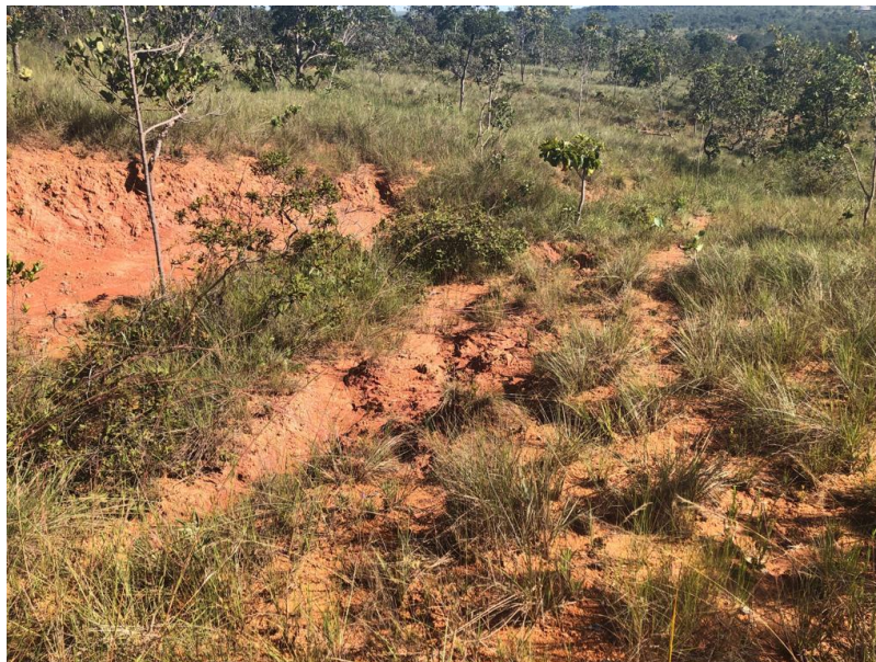
Figura 25: Erosão1- Erosão em sulcos ramificada.
