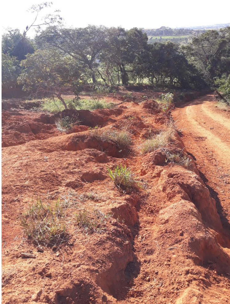
Figura 40-Erosão em sulcos na propriedade sem nome
