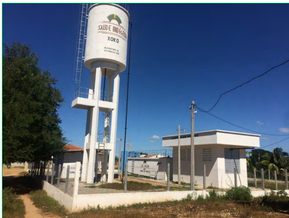
Figura 18 – Estação de Tratamento de Água (ETA) e reservatório de 50.000 L. Fonte: DHF Consultoria (2019).
