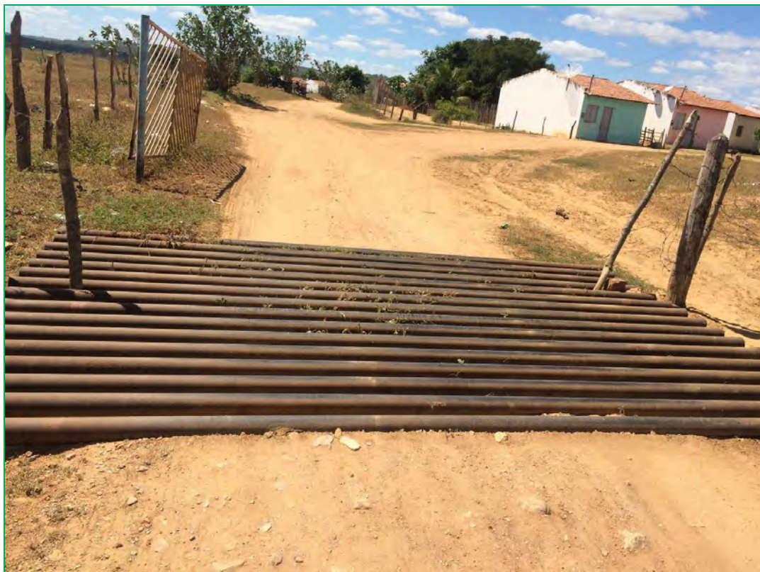
Figura 23 – Mata-burro existente no interior na TI Caiçara / Ilha de São Pedro. Fonte: DHF Consultoria (2019).
