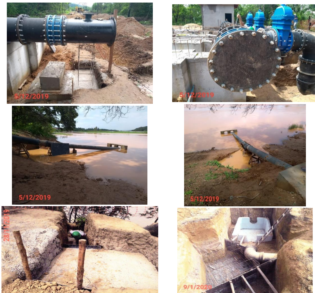
Figura 22 - Acervo fotográfico das obras e serviços de implantação do sistema de captação e adução de água bruta no município de Pirapora/MG (Fonte: INOVESA, 2019 e 2020).
