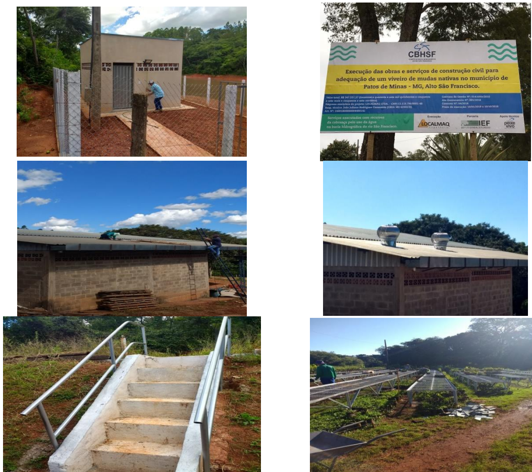
Figura 23 - Acervo fotográfico das obras e serviços de construção civil para adequação de um viveiro de mudas nativas no município de Patos de Minas/MG (Fonte: LOCALMAQ, 2019).
