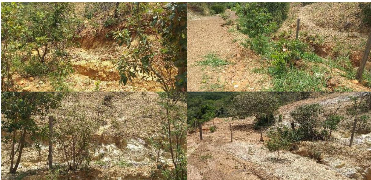
Figura 4.29 – Estrada que passa próximo à propriedade 9 com erosão
