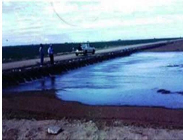
Figura 75 – Área com sistema de irrigação por inundação em fase de enchimento
