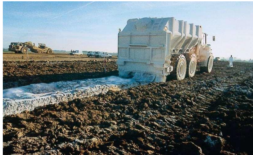
Aplicação de pozolana na areia e lama de barragem
