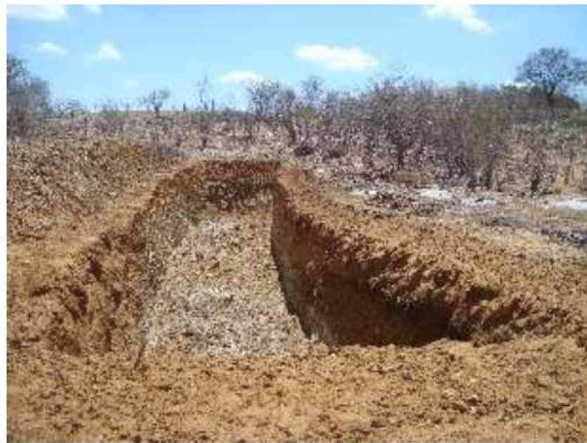
FIGURA 3: Barreiro trincheira após cavação
