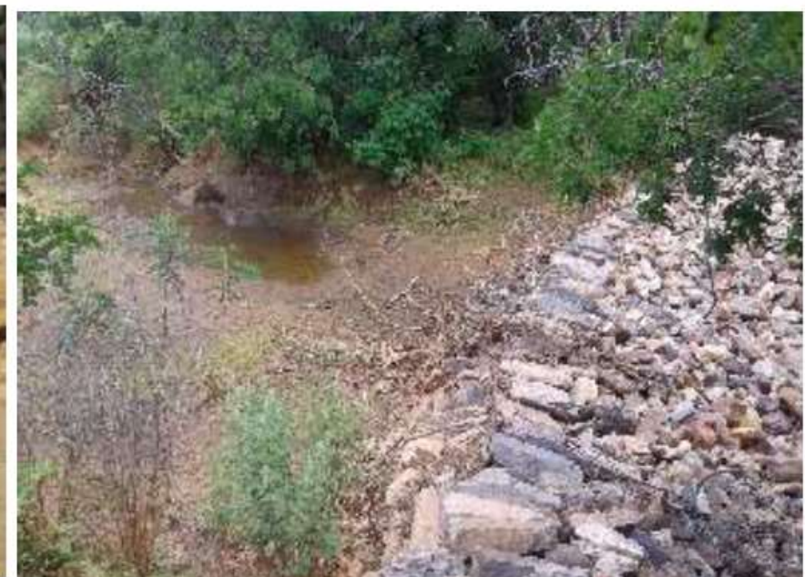
FIGURA 6: Barramento de pedra após chuva
