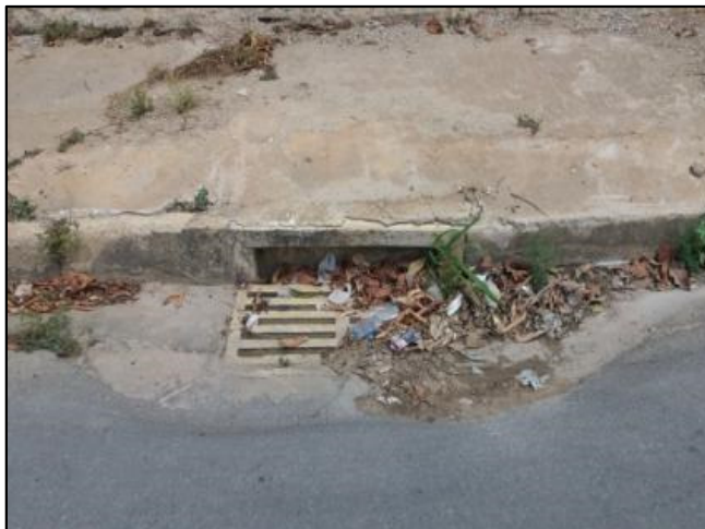
Figura 51: Estado de conservação dos bueiros e bocas-de-lobo
