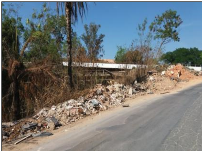
Figura 48: Disposição inadequada de RCC ao lado da linha férrea
