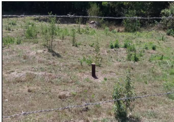
Figura 20: Poço perfurado desativado - Bairro Maravilhas
