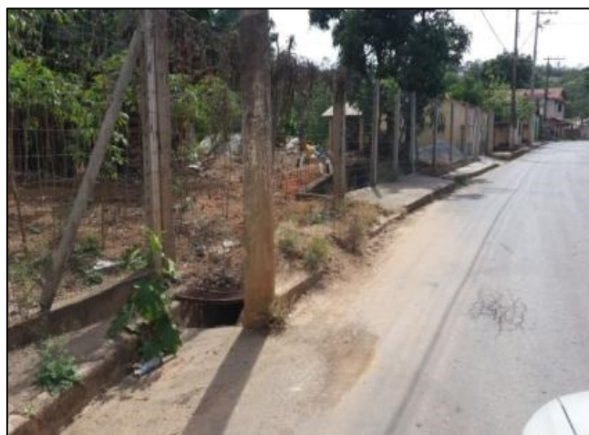
Figura 52: Estado de conservação dos bueiros e bocas-de-lobo
