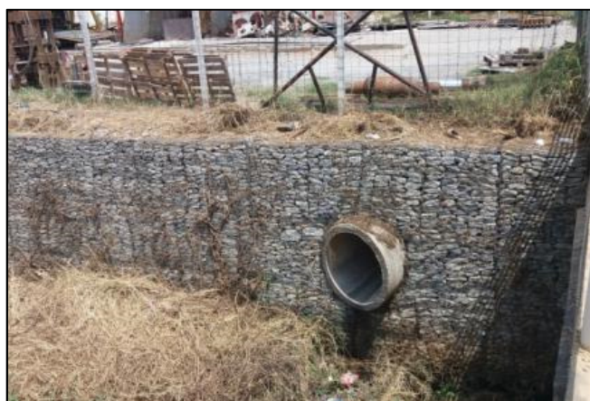
Figura 54: Sistema de macrodrenagem existente.
