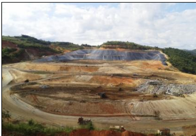
Figura 49: Central de tratamento de resíduos Macaúbas Fonte: Central de tratamento de resíduos Macaúbas, 2017
