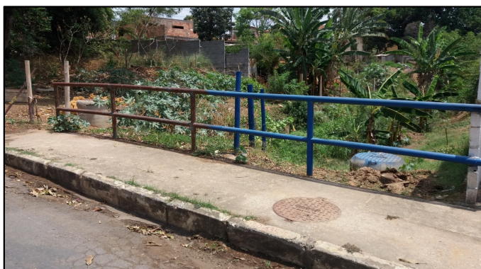
Figura 33: Poços de visitas
