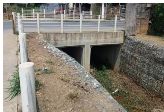
Figura 55: Sistema de macrodrenagem existente.
