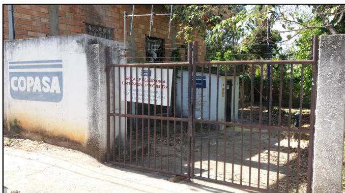
Figura 23: Poço C-02 em Inácia de Carvalho
