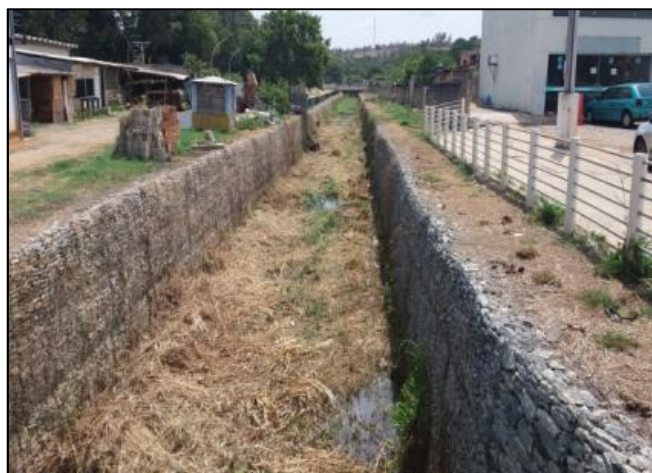
Figura 53: Sistema de macrodrenagem existente.
