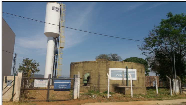
Figura 16: Reservatórios localizados no bairro Dom Pedro I para atendimento à sede
