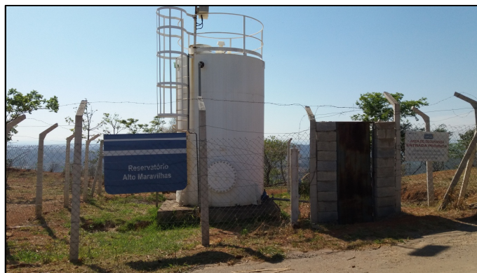
Figura 27: Reservatório para atender Alto Maravilhas Fonte: PRO BRAS, 2017
