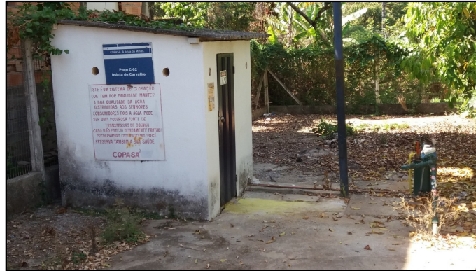
Figura 24: Poço C-02 em Inácia de Carvalho
