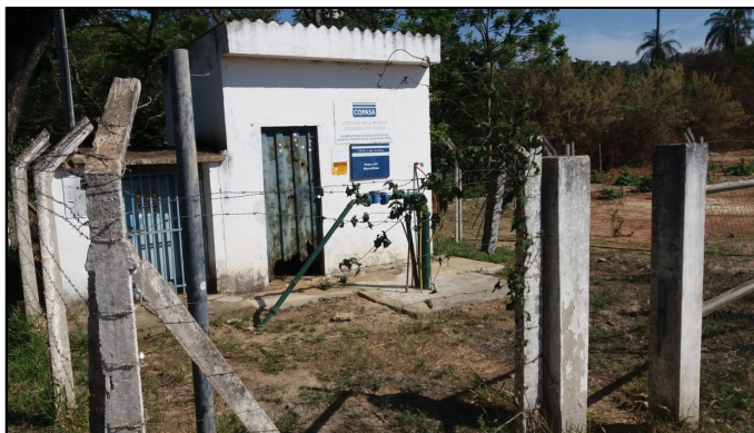
Figura 17: Poço C-01 - Bairro Maravilhas
