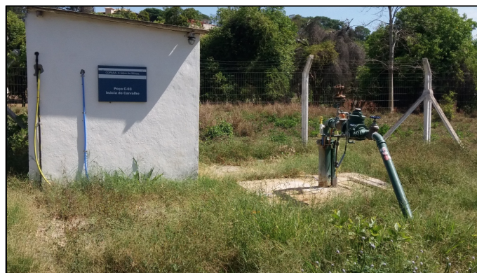
Figura 25: Poço C-03 em Inácia de Carvalho
