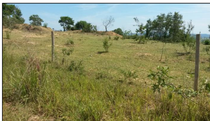
Figura 25: Vista parcial da antiga área de disposição.
