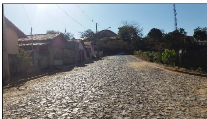
Figura 34: Rua de pedra, Bairro São Geraldo
