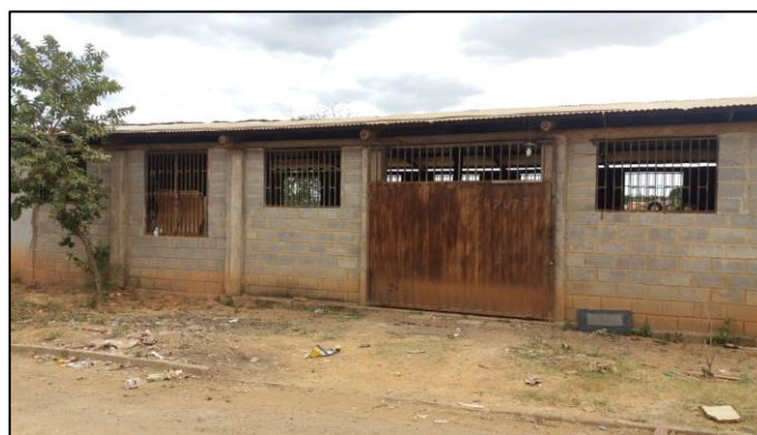
Figura 26: Galpão de triagem
