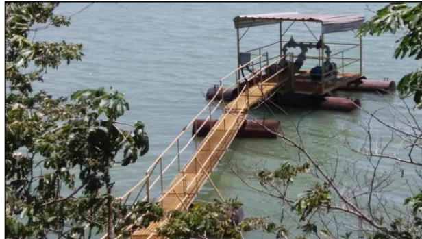
Figura 11: Balsa de captação superficial de água bruta
