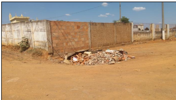
Figura 31: Disposição inadequada de RCC, Avenida Tancredo Neves
