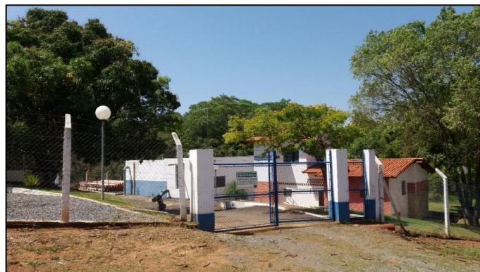
Figura 15: Estação de Tratamento de Água
