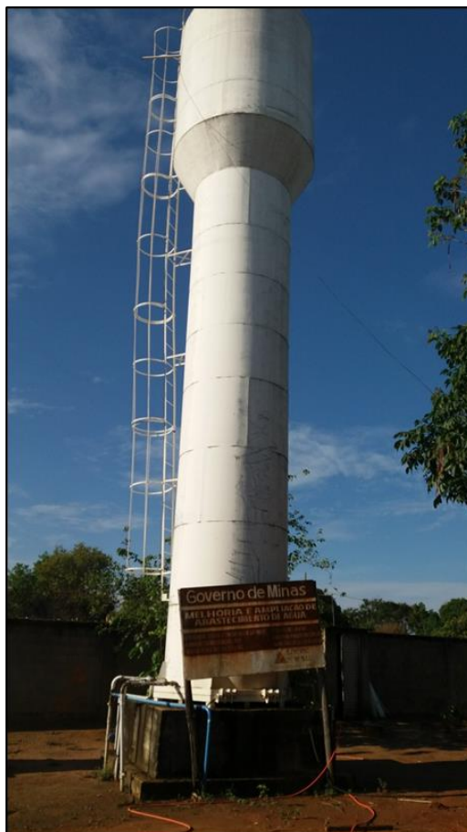
Figura 130: Reservatório – Lagoa do Meio
