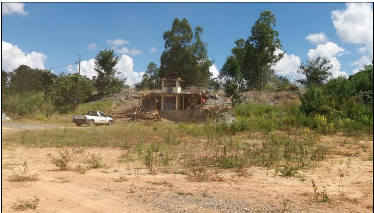
Figura 209: Ponto de lançamento clandestino P7
