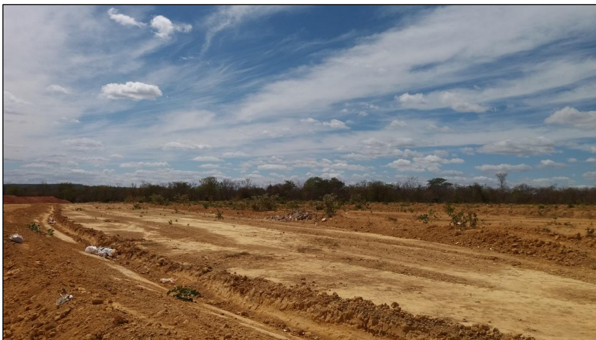
Figura 177: Área de vala encerrada
