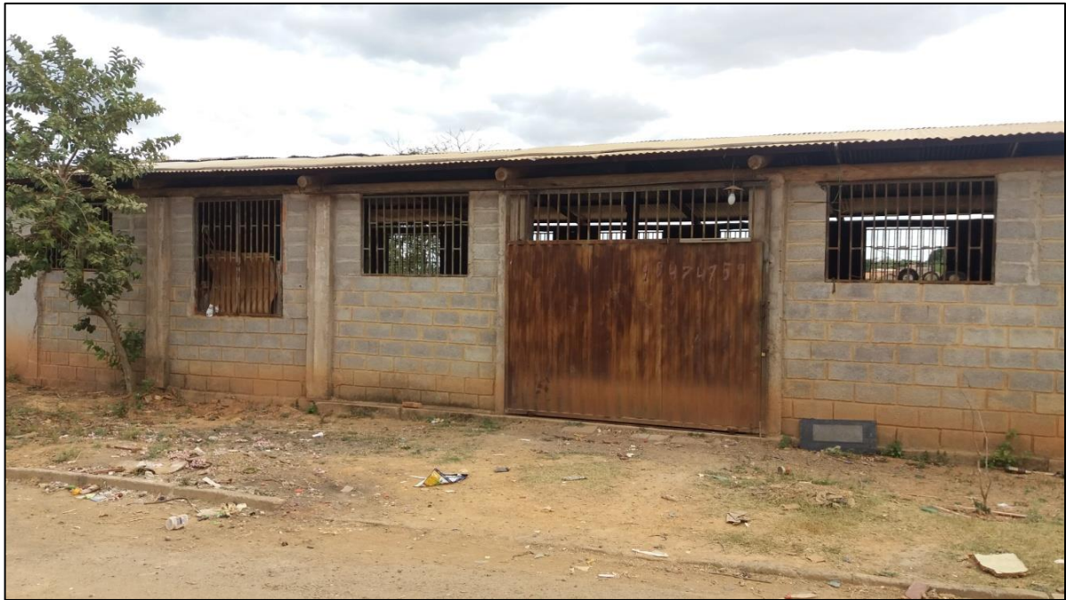
Figura 187: Galpão de triagem
