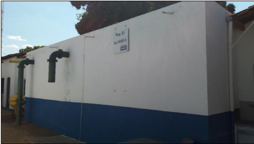
Figura 84: Reservatório de 254 m 3
