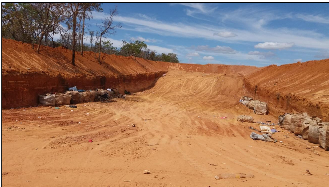
Figura 178: Trincheira aberta para a disposição de resíduos
