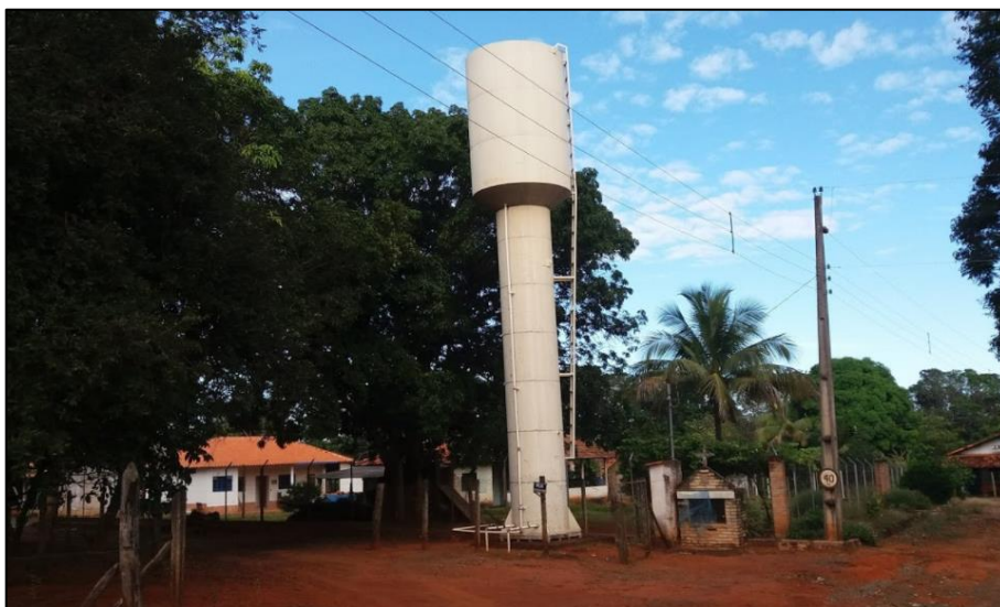
Figura 104: Reservatório – Estância das Garças
