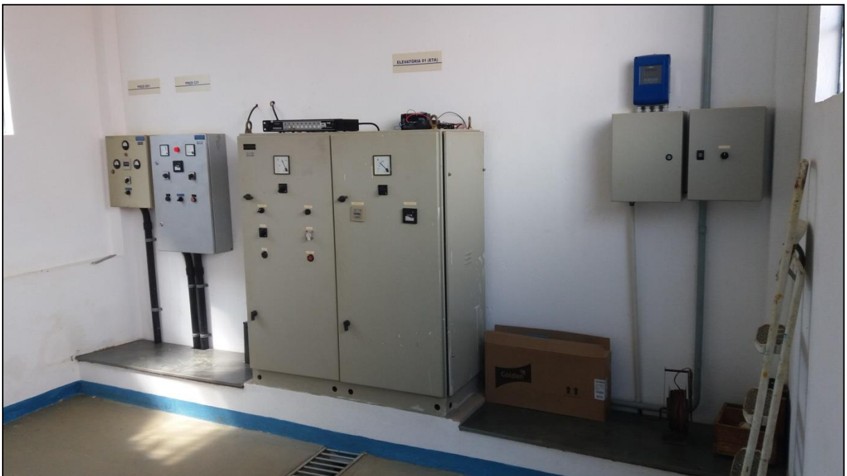
Figura 78: Casa de máquinas na ETA
