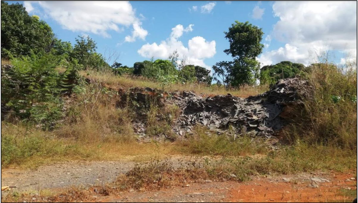
Figura 206: Ponto de lançamento clandestino P4
