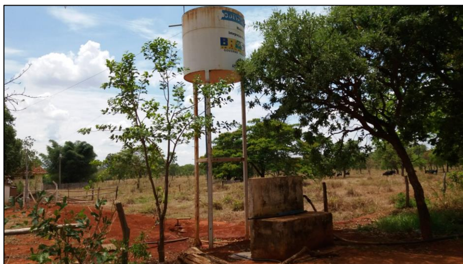
Figura 143: Reservatório – Saco Fechado
