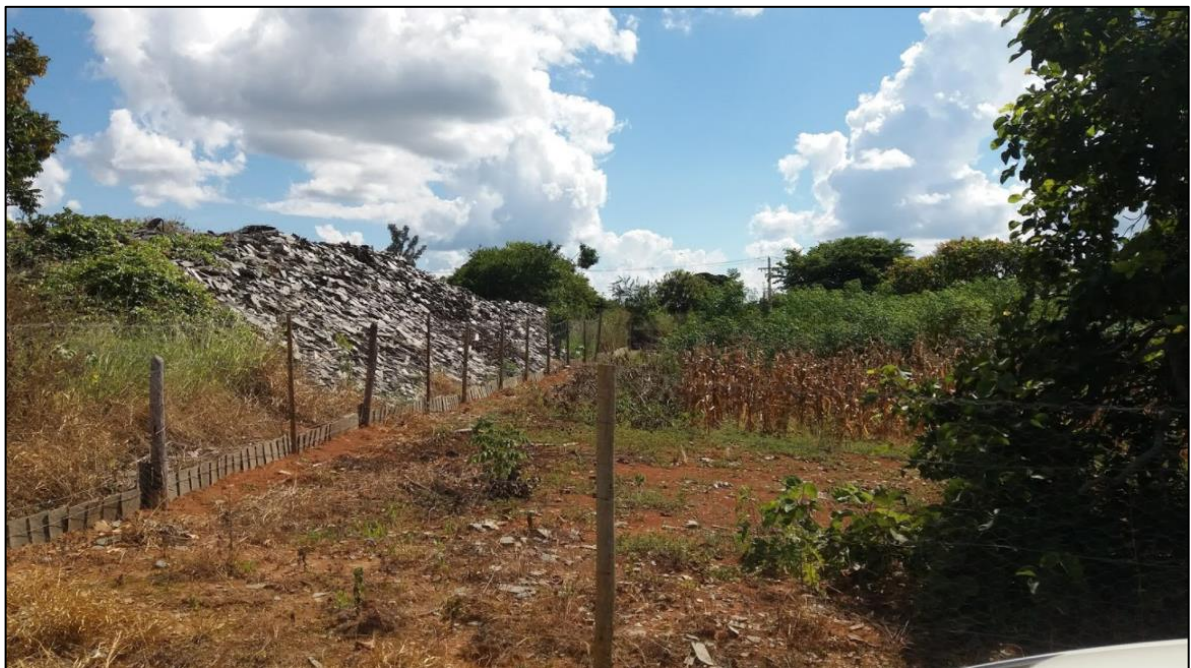
Figura 205: Ponto de lançamento clandestino P3
