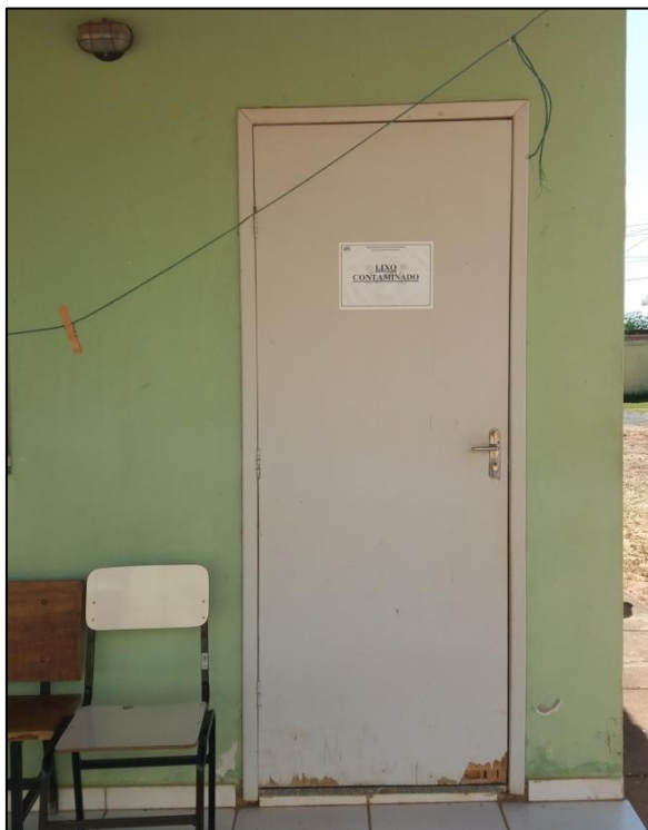
Figura 193: Sala de acondicionamento dos RSS
