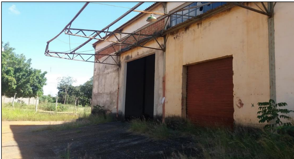
Figura 200: Local de armazenamento de pneumáticos
