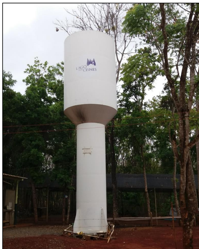
Figura 112: Reservatório 2 – Lago dos Cisnes
