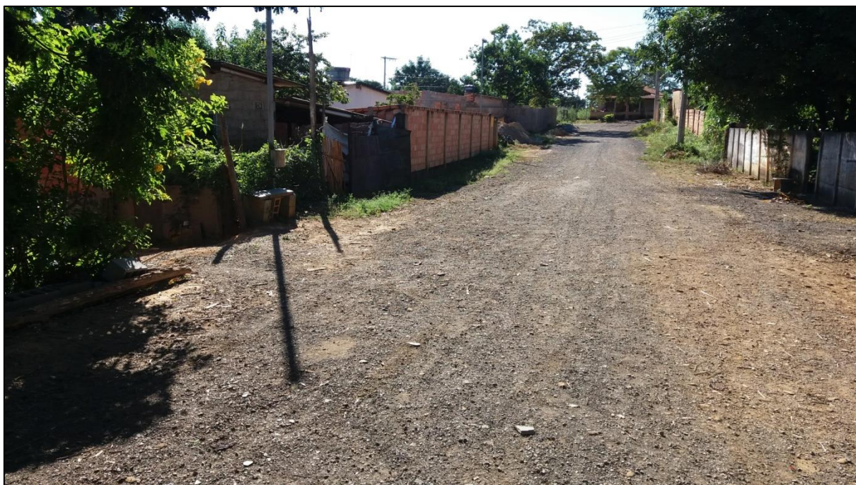
Figura 51: Via sem pavimentação
