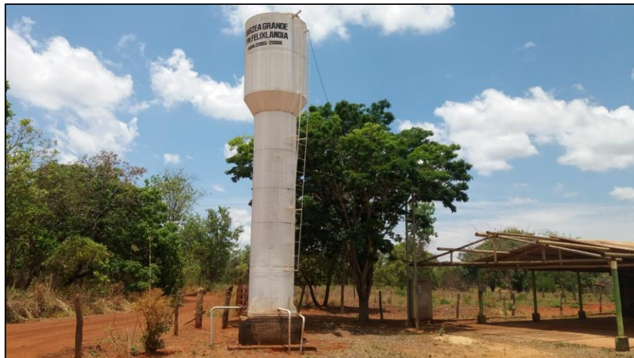
Figura 149: Reservatório – Várzea Grande
