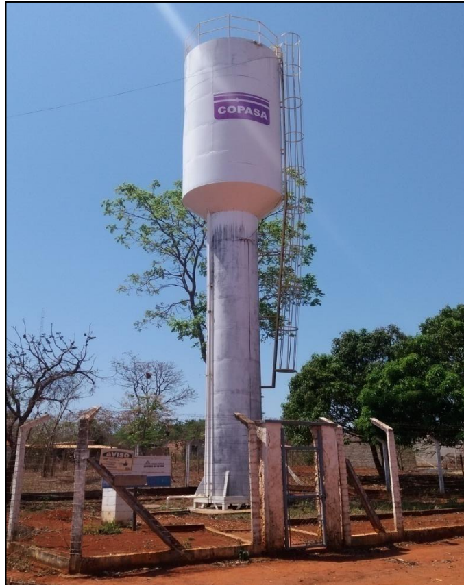
Figura 99: Reservatório de 30 m 3 de São José do Buriti
