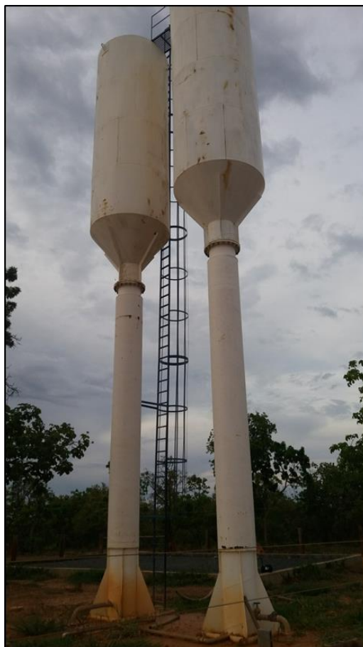
Figura 108: Reservatório – La Poveda
