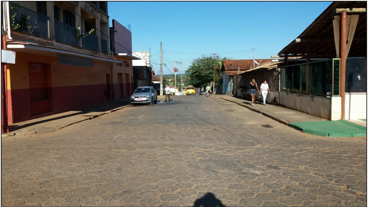
Figura 49: Via pavimentada com bloco sextavado
