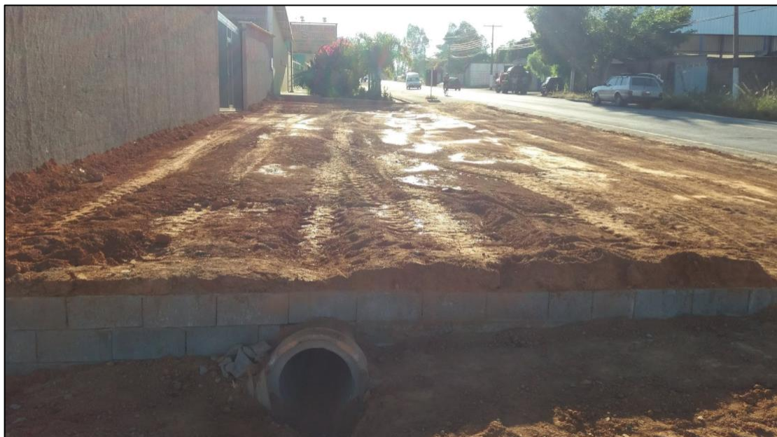
Figura 222: Sistema de drenagem sendo implantado na Rodovia Municipal José Mauro Gonçalves
