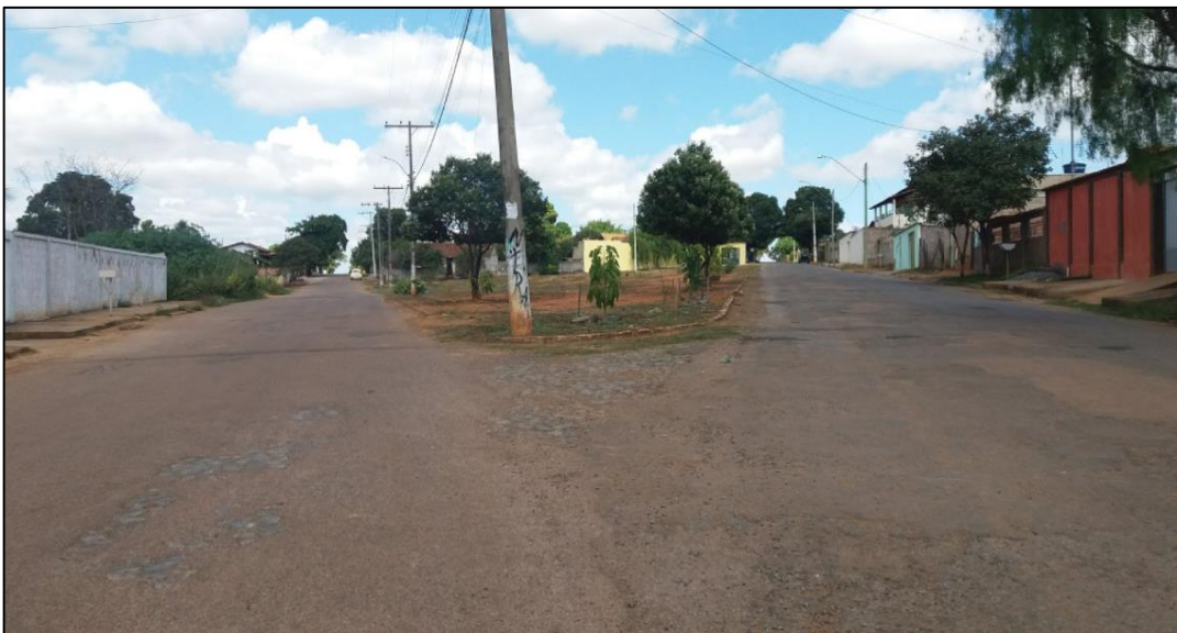
Figura 231: Entrocamento av. C com av. EPAMIG – bairro Ribeirão do Bagre
