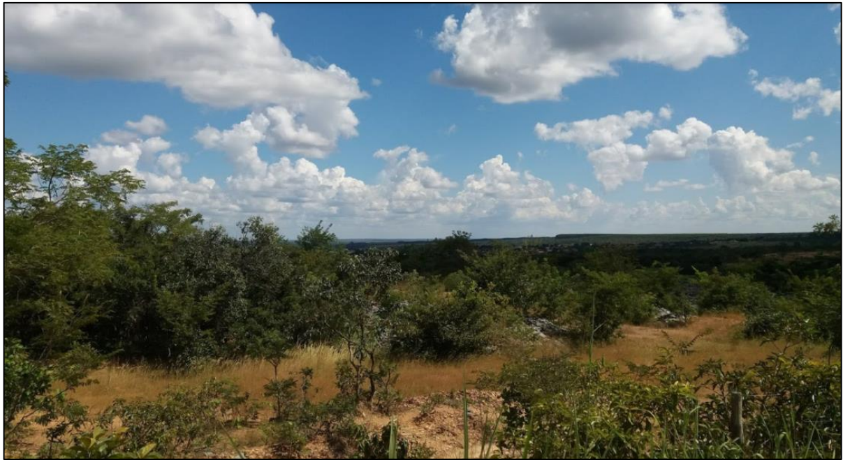
Figura 210: Ponto de lançamento clandestino P8, Cercadinho das Alterosas
