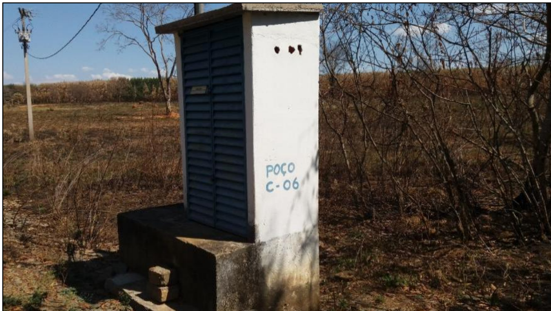
Figura 63: Poço C-06 – Casa de bomba
