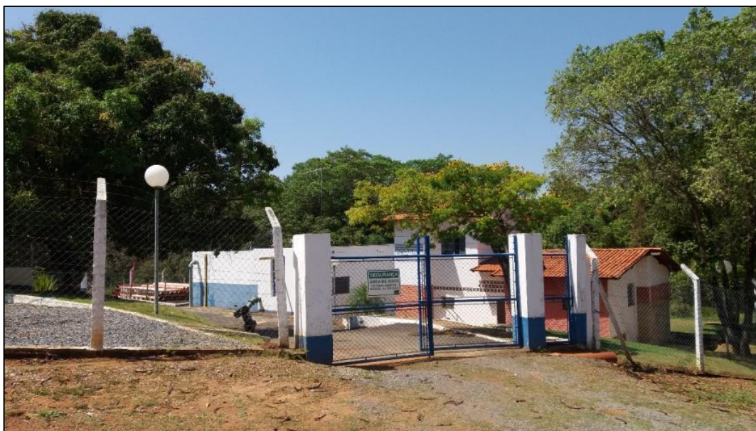
Figura 67: Estação de Tratamento de Água
