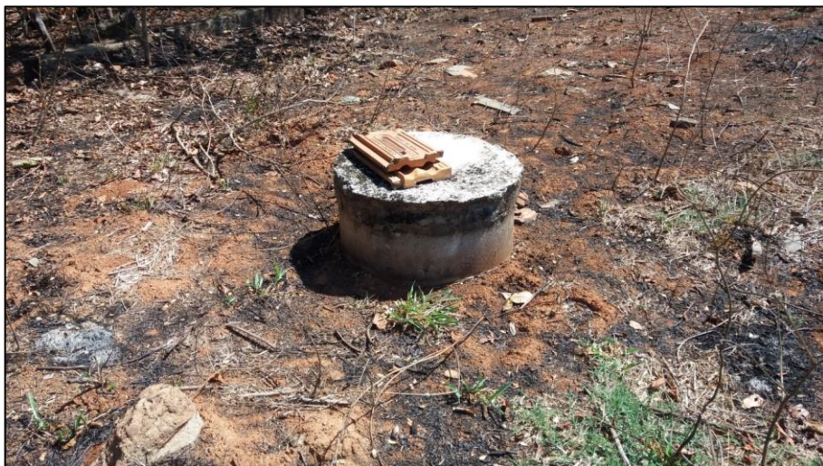
Figura 160: Poço de visita 1
