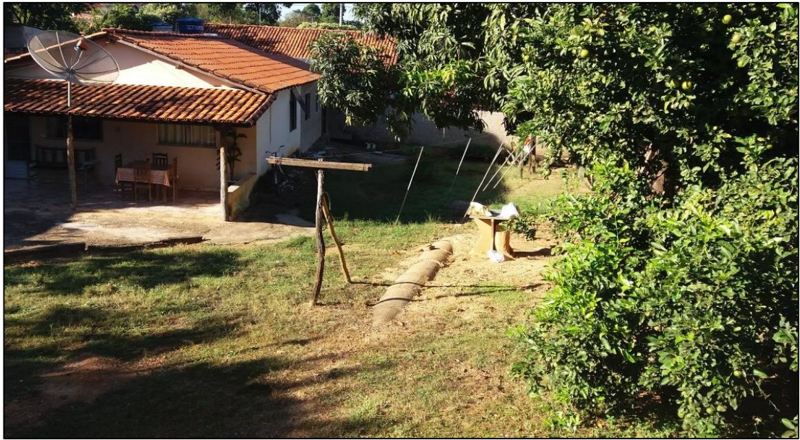
Figura 240: Final da rede de drenagem 01 antes de ser descartado no ribeirão do Bagre
