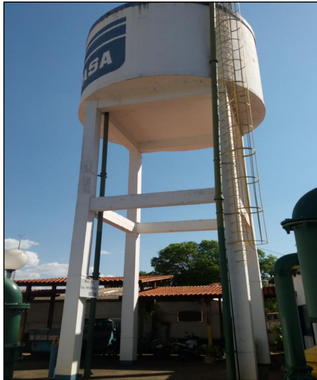
Figura 86: Reservatório de 100 m 3
