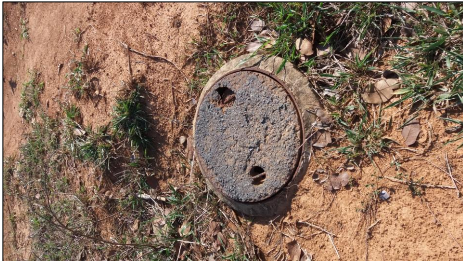
Figura 162: Poço de visita 3
