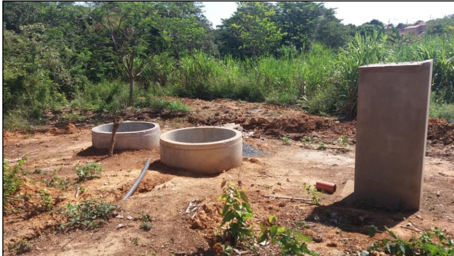
Figura 161: Poço de visita 2
