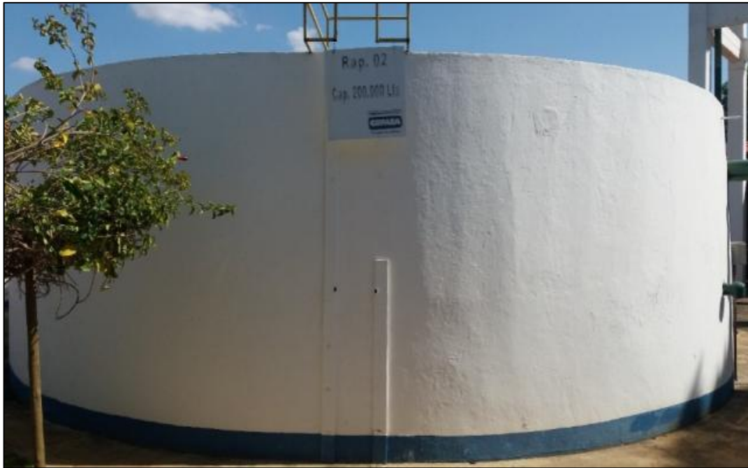
Figura 83: Reservatório de 200 m 3
