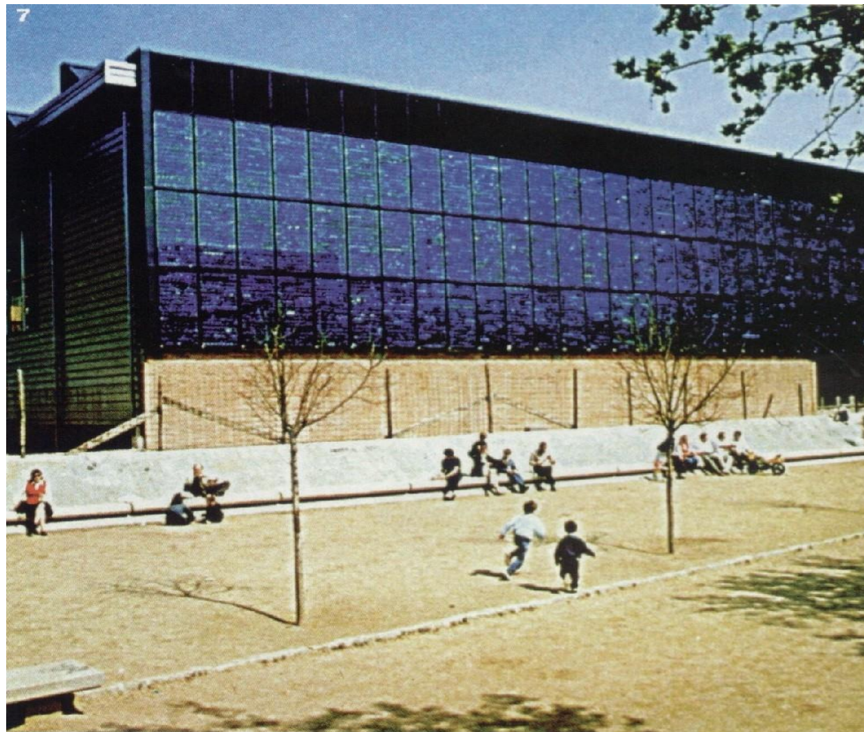
Biblioteca -Espanha 33,5 kWp
