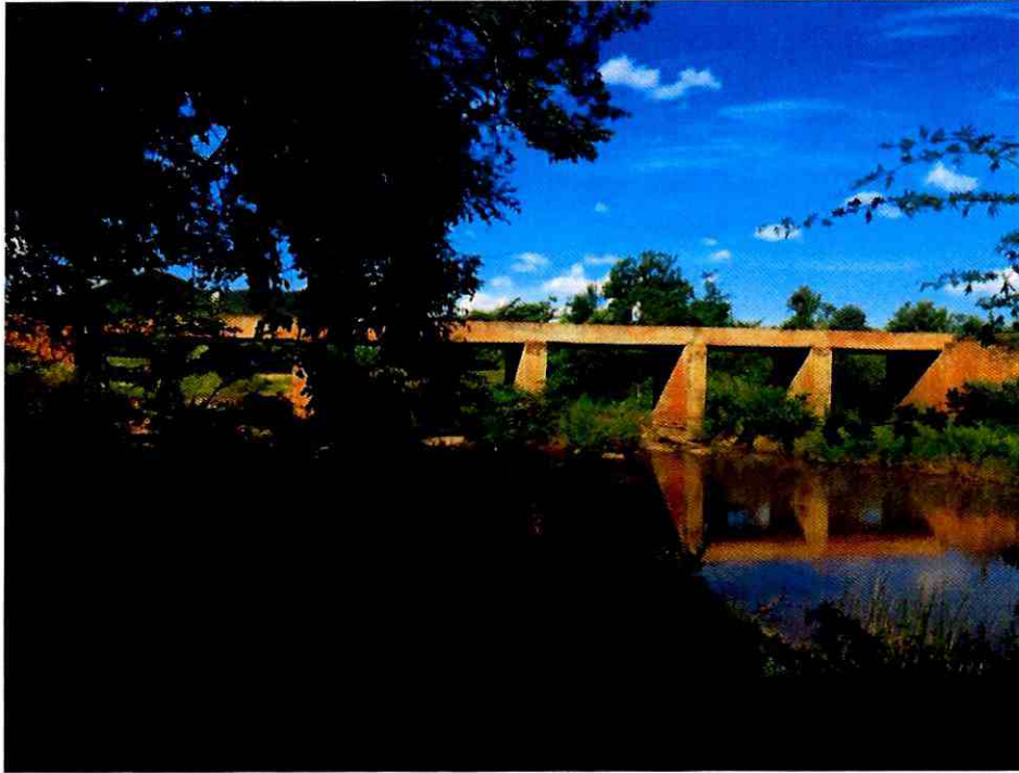
Foto-1 Ponte sobreo rio da Caixa
