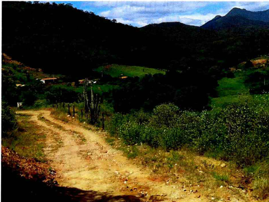
Foto-8 Foto do alto da bacia de acumulação do sítio da barragem do rio da Caixa.
