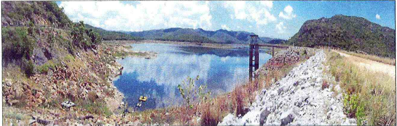
Figura 7. Açude Zabumbão e captação flutuante da EMBASA (12/11/2013).
