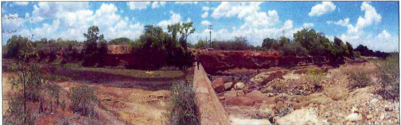
Figura 8. Reservatório Roça Velha e captação flutuante da EMBASA (12/11/2013). Montante à esquerda.
