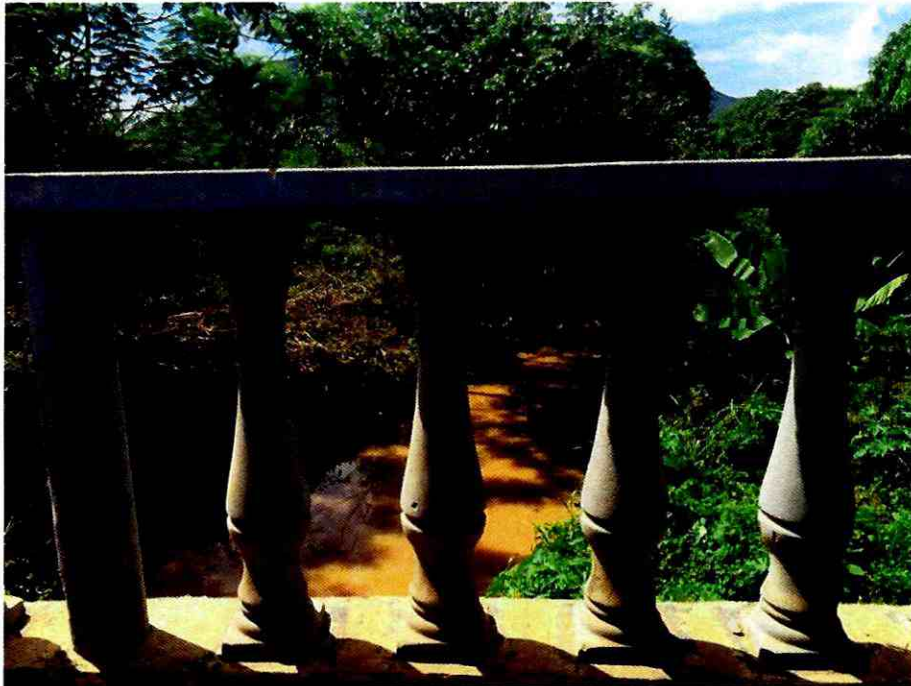
Foto-2 Ponte sobre o rio dos Remédios
