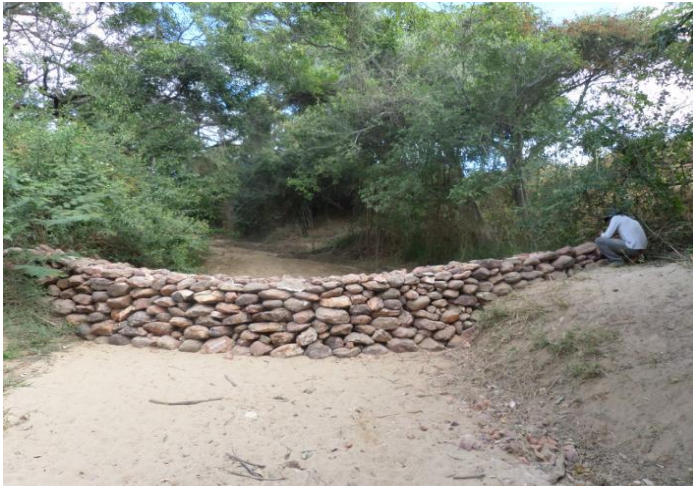
Dique de contenção (Paratinga - BA)
