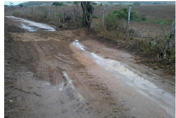
Adequação de estradas (Feira Grande - AL)
