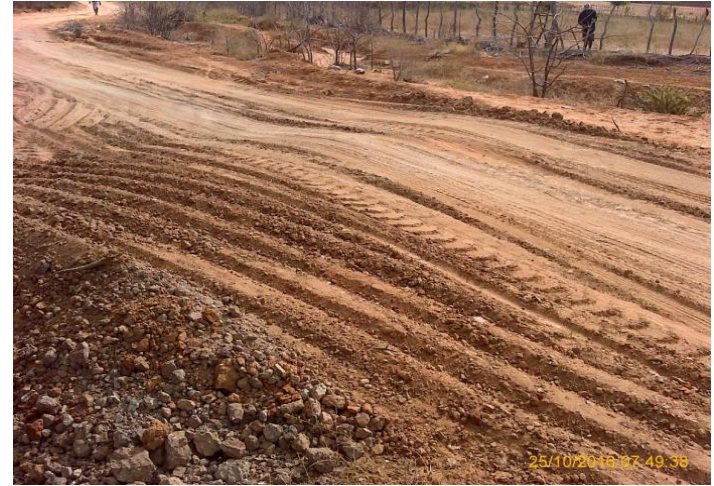
Adequação de estrada (Ibimirim - PE)
