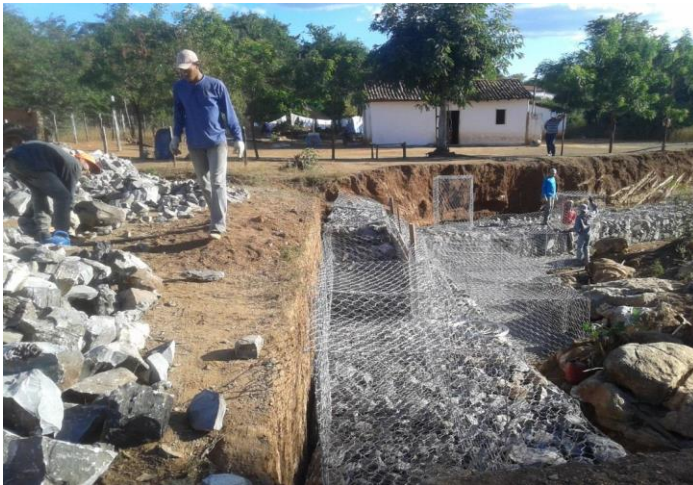
Estabilização de erosão (S. Maria da Vitória - BA)
