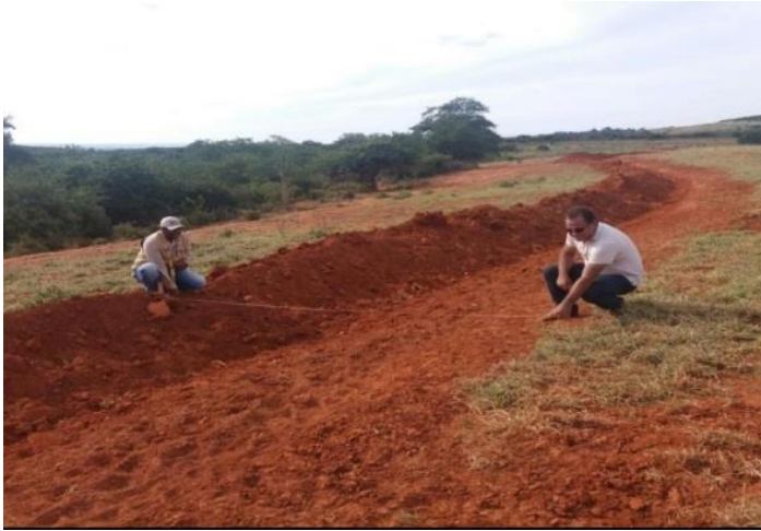
Construção de terraços (Morro do Chapéu - BA)
