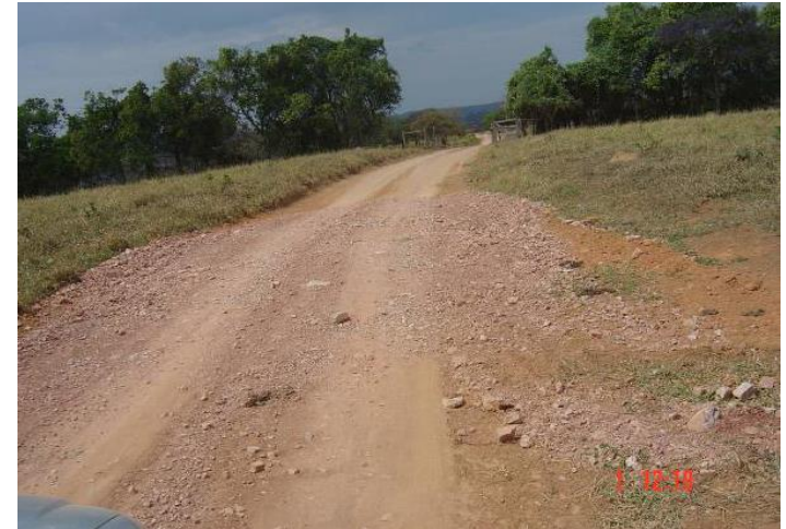
Adequação de estrada rural (Divinópolis - MG)
