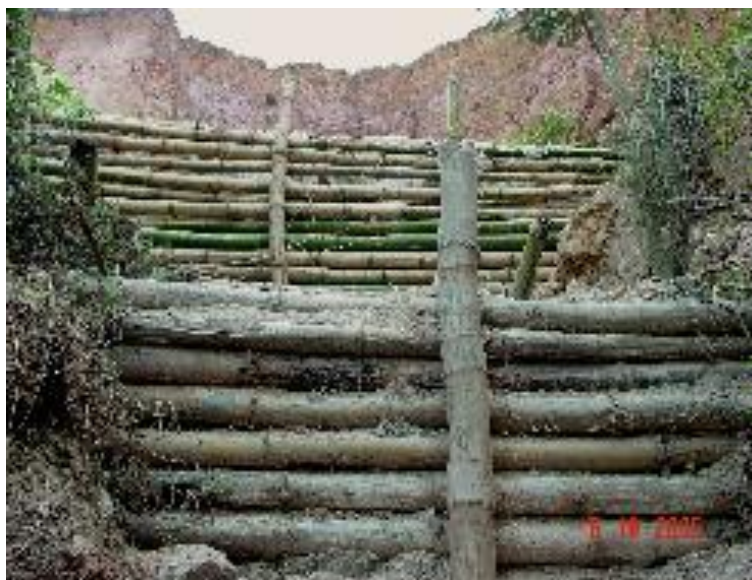
Foto 10: Exemplo de paliçada construída com bambu.
