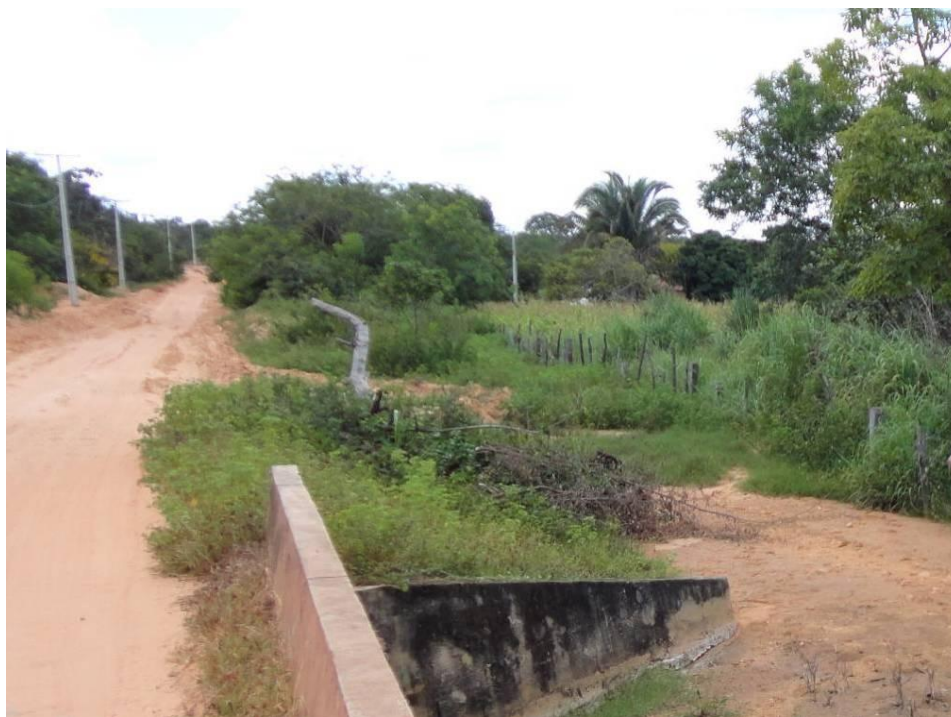
Foto 5 - Carreamento de sedimentos arenosos da estrada sendo lançados no leito do rio.
