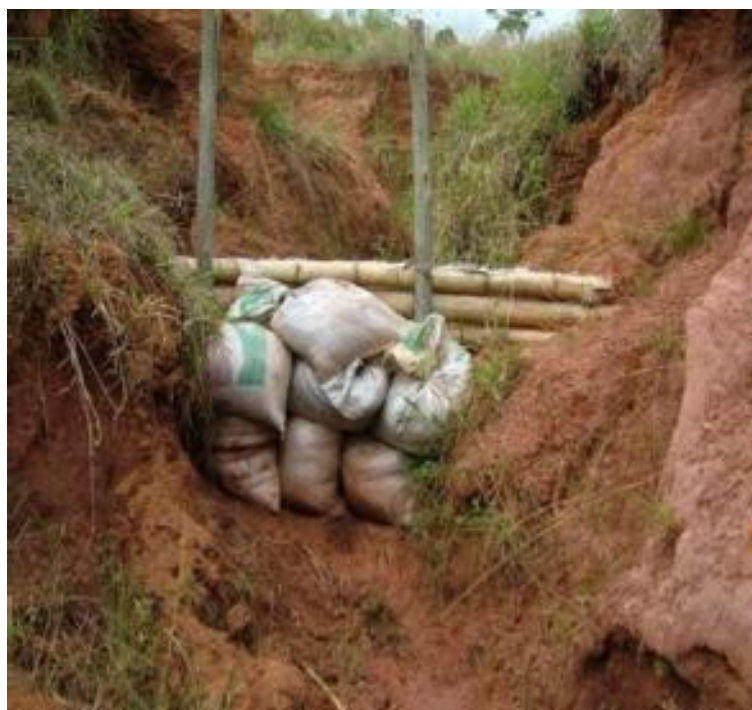
Foto 9: Representação de uma paliçada feita de bambu e sacos com terra servindo escora.
