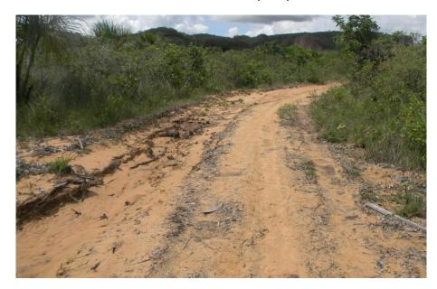
Figura 6.4 – Trecho de estrada vicinal sem manutenção adequada na sub-bacia do Rio Pardo,
