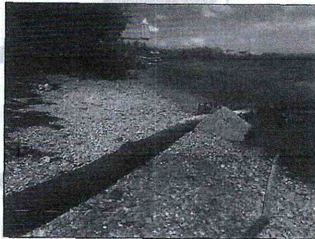
Figura 3 – Mangote que distribui a água da captação até a elevatória que distribui para a ETA.
