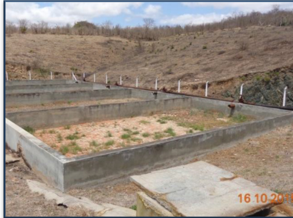
Figura 33 - Unidade de secagem do lodo na ETE do município de Miguel Calmon - BA (Fonte: GERENTEC, 2015).
