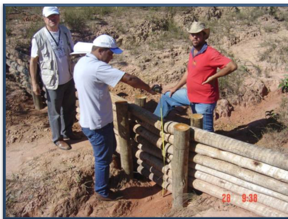
Figura 41 - Equipe de Fiscalização realizando medição de paliçada construída em Felixlândia - MG, Alto São Francisco. (Fonte: IRRIPLAN, 2015)
