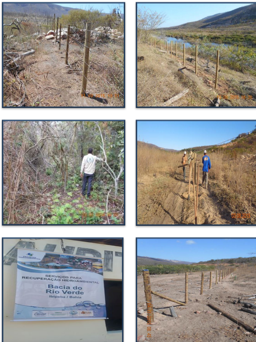
Figura 49 - Acervo fotográfico do projeto de recuperação hidroambiental da bacia do Rio Verde (Fonte: IRRIPLAN, 2015)
