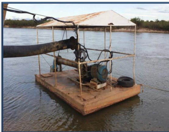
Figura 31 - Captação flutuante de água no Rio Grande no município de Barra - BA (Fonte: ÁGUA E SOLO, 2015).
