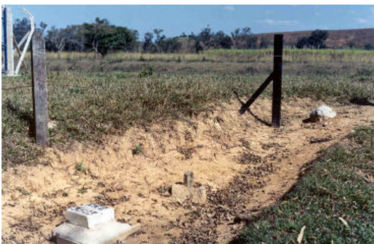
Foto 4. Erosão solapando o RN e a seção de régua
