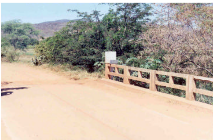
Foto 3. Locação inadequada da estação, na murada da ponte, facilitando o vandalismo
