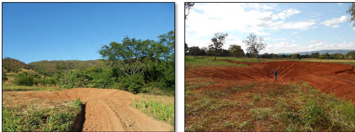
Figura 9: Barraginhas executadas nos terraços;
