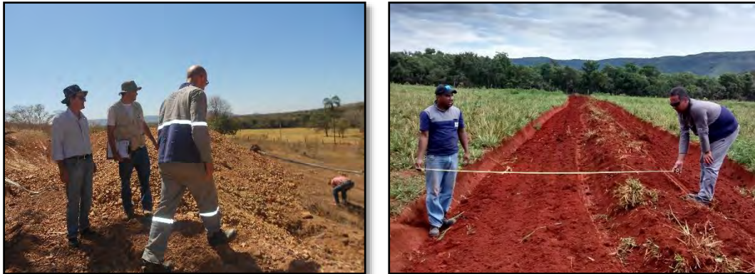
Figura 4: Supervisão das obras;
