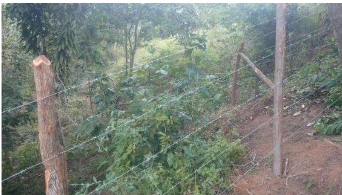
Figura 25 - Cercamento de APP executado. Fonte: Arquivo fotográfico GOS Florestal.
