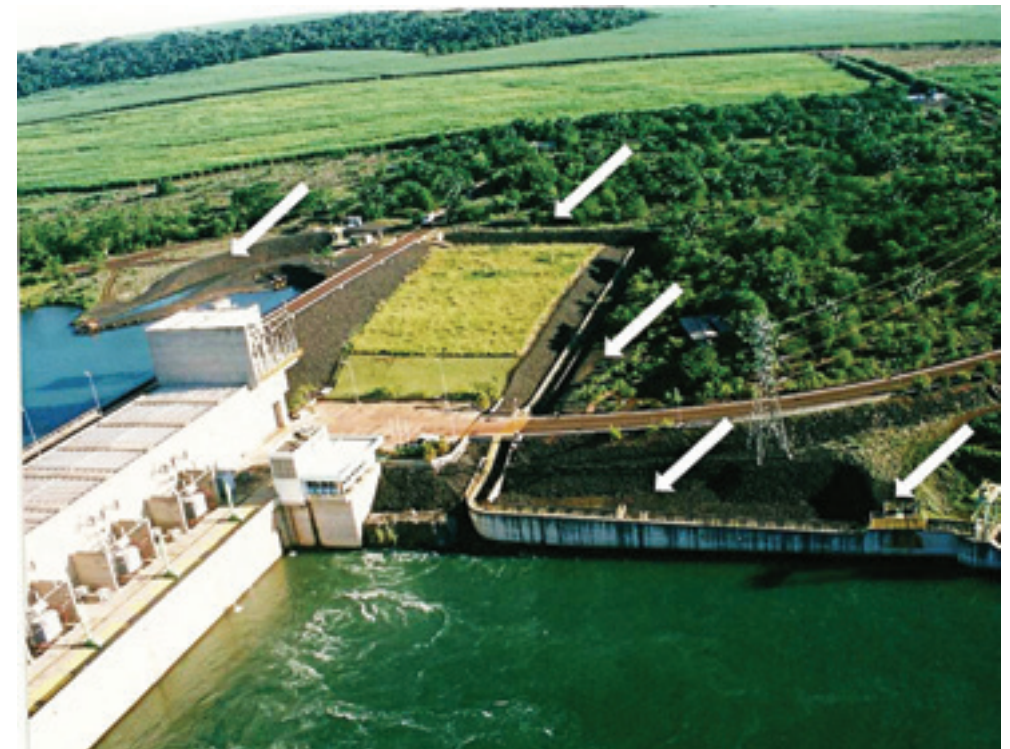
FIGURA 2 – Visão geral do canal de fuga da UHE Igarapava, mostrando a escada (setas brancas) construída e que permite deslocamentos dos peixes de jusante para montante. Foto: Luiz Gustavo M. Silva.
