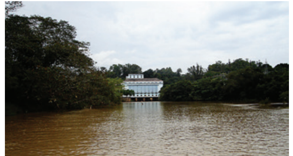
FIGURA 2 – Estação JGF no rio Pará, situada a jusante do canal de fuga da UHE Gafanhoto. Local utilizado para marcação de peixes. Foto: Gilmar Bastos Santos.
