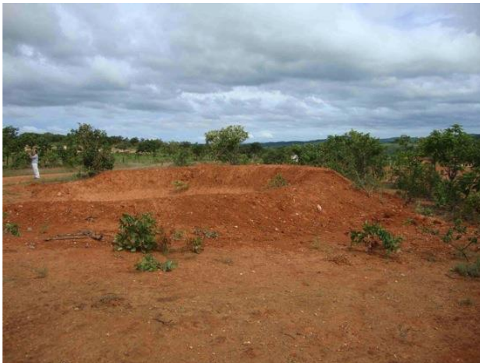
Figura 31 - Vista lateral da mesma barraginha da foto acima.
