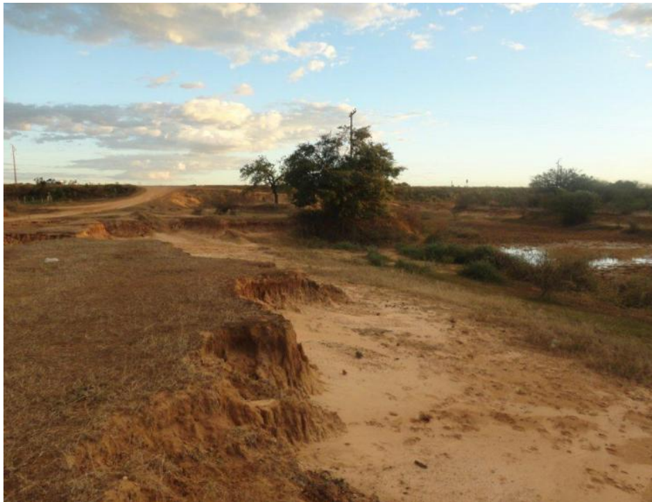
Figura 15 - Trecho inicial da estrada numa antiga jazida de material cascalhoso onde está indicado terraceamento – ao fundo está a BA-349.
