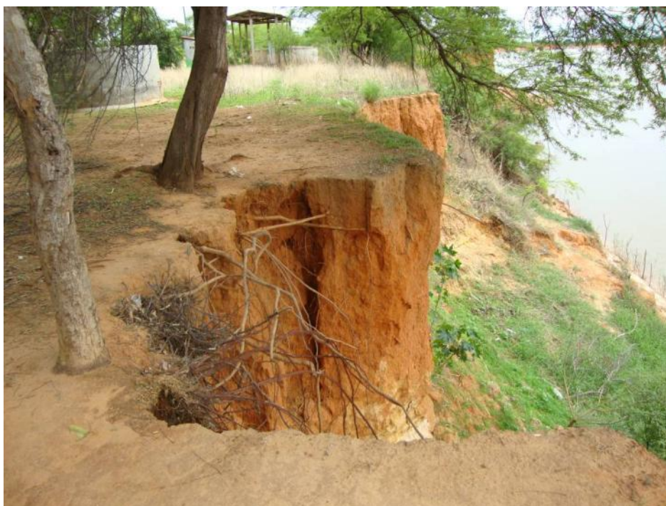
Fotografia 2 – Processos erosivos nas margens mostrando raízes expostas.
