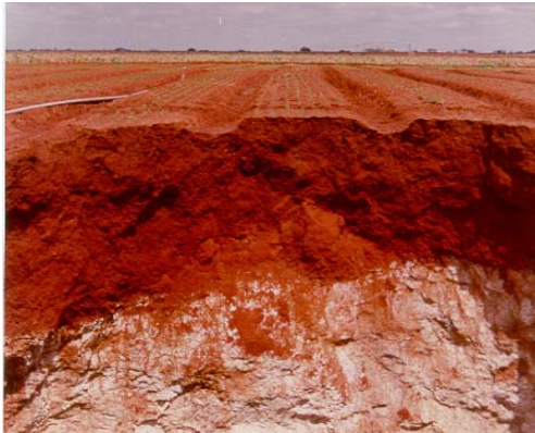
Foto 6. Evidências de degradação do solo e desestabilização da estrutura do aquífero. Solapamento de dolina em consequência da sobre-exploração.
