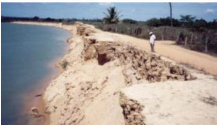
**Foto 2. Visão geral da margem do Perímetro Irrigado Cotinguiba-Pindoba (ME-52). Em primeiro plano, restos do dique de proteção contra cheias que localmente constitui a parte superior do barranco, tendo um comportamento mais rígido. Notar a formação da franja ou “saia” formada pelos depósitos de fluxos de grãos.**
