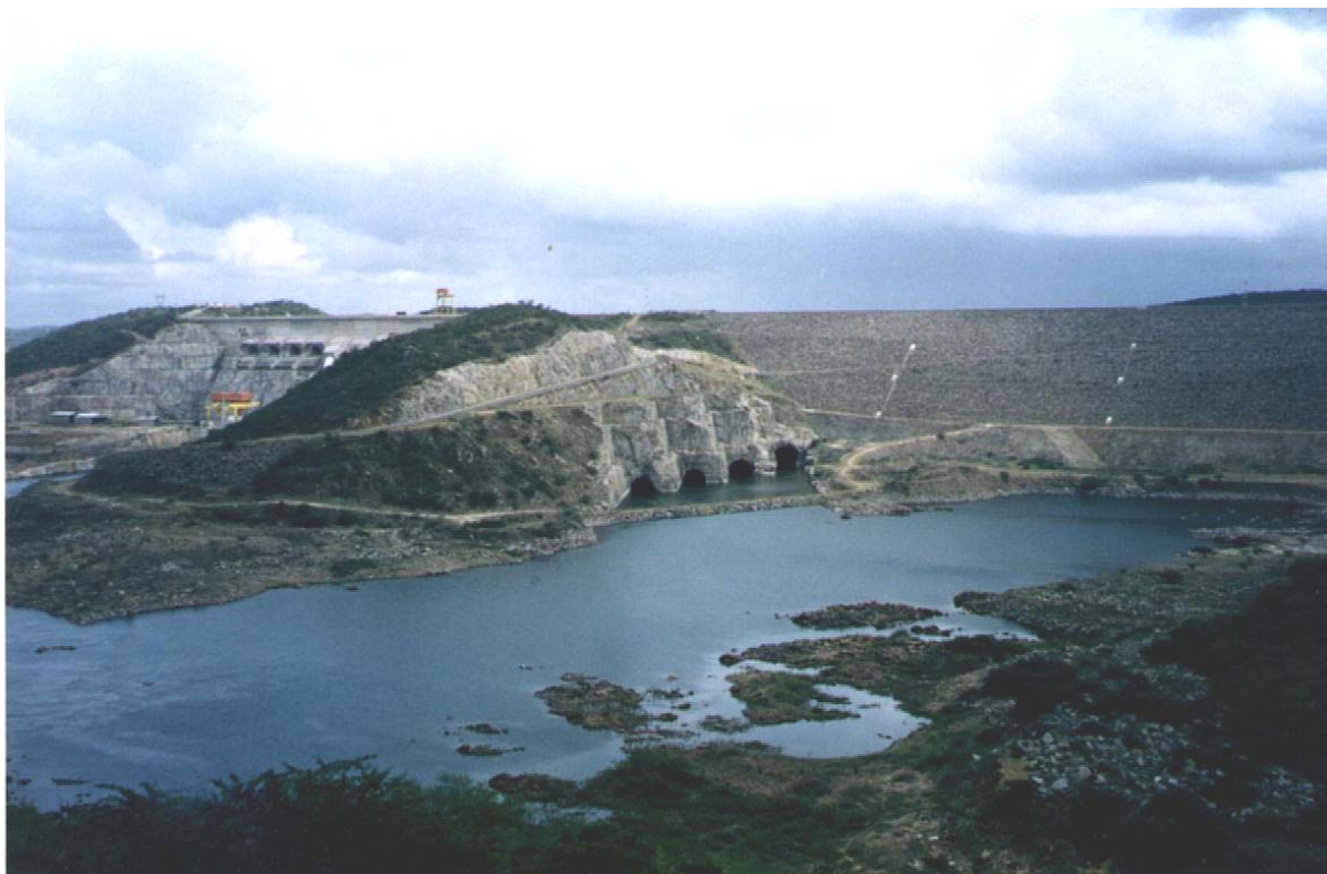
Foto 7. Vista da barragem da Usina Hidroelétrica de Xingó (julho de 2000).
