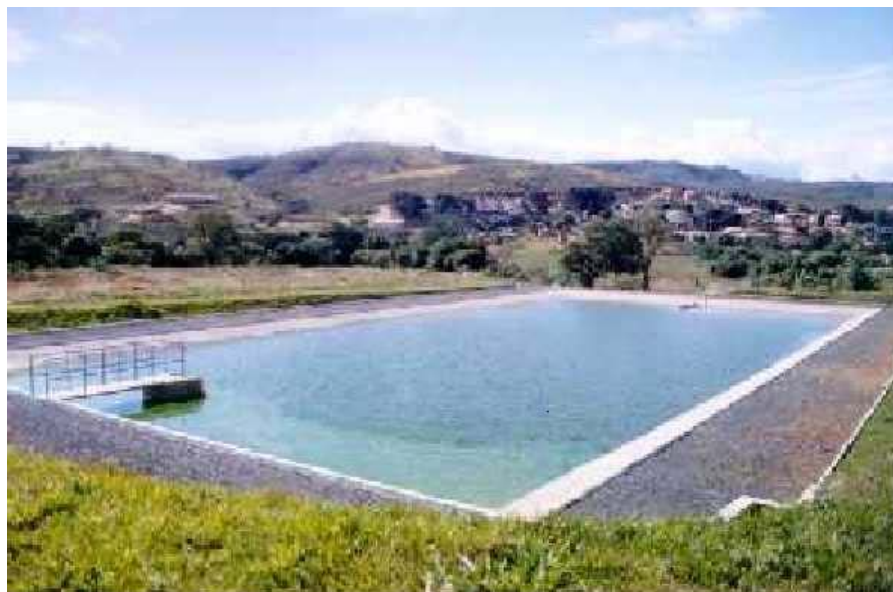
Foto 11. Vista parcial da estação de tratamento de esgotos de Juramento
