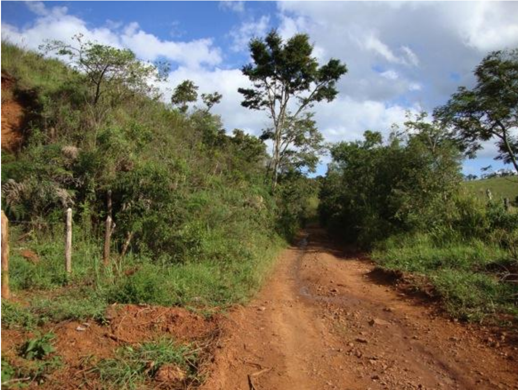
Figura 6: Processo erosivo instalado em estrada rural ao lado do Rio Bananeiras e sem medidas de controle de águas pluviais.
