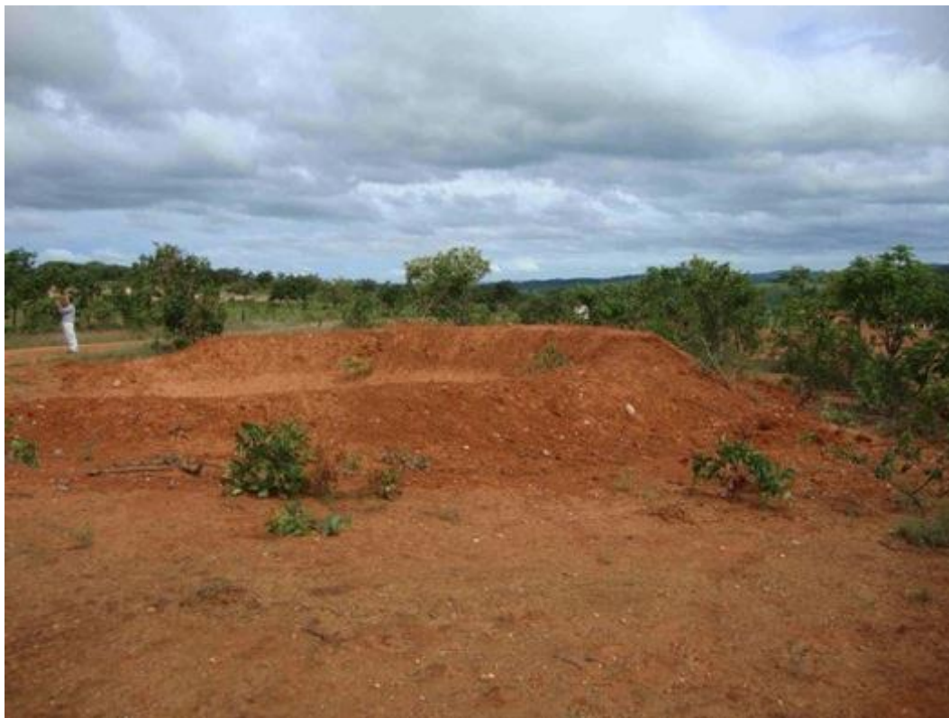
Figura 28: Vista lateral da mesma barragem da foto acima.
