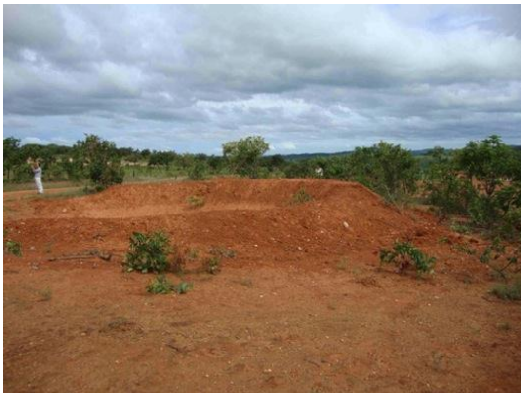
Figura 25: Vista lateral da mesma barragem da foto acima.
