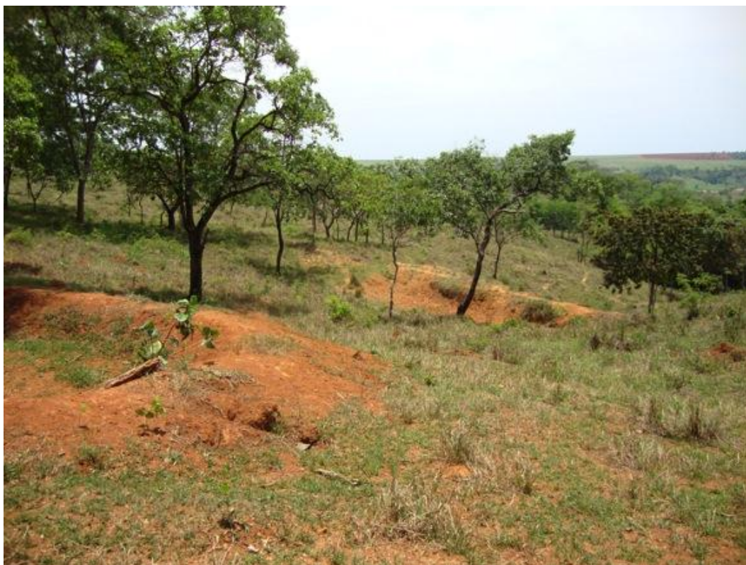
Figura 4: Observa-se em área de Latossolo Vermelho alguns dispositivos para controle das águas pluviais provenientes de estrada a montante, observando-se também árvores remanescentes de Cerrado "sensu stricto".
