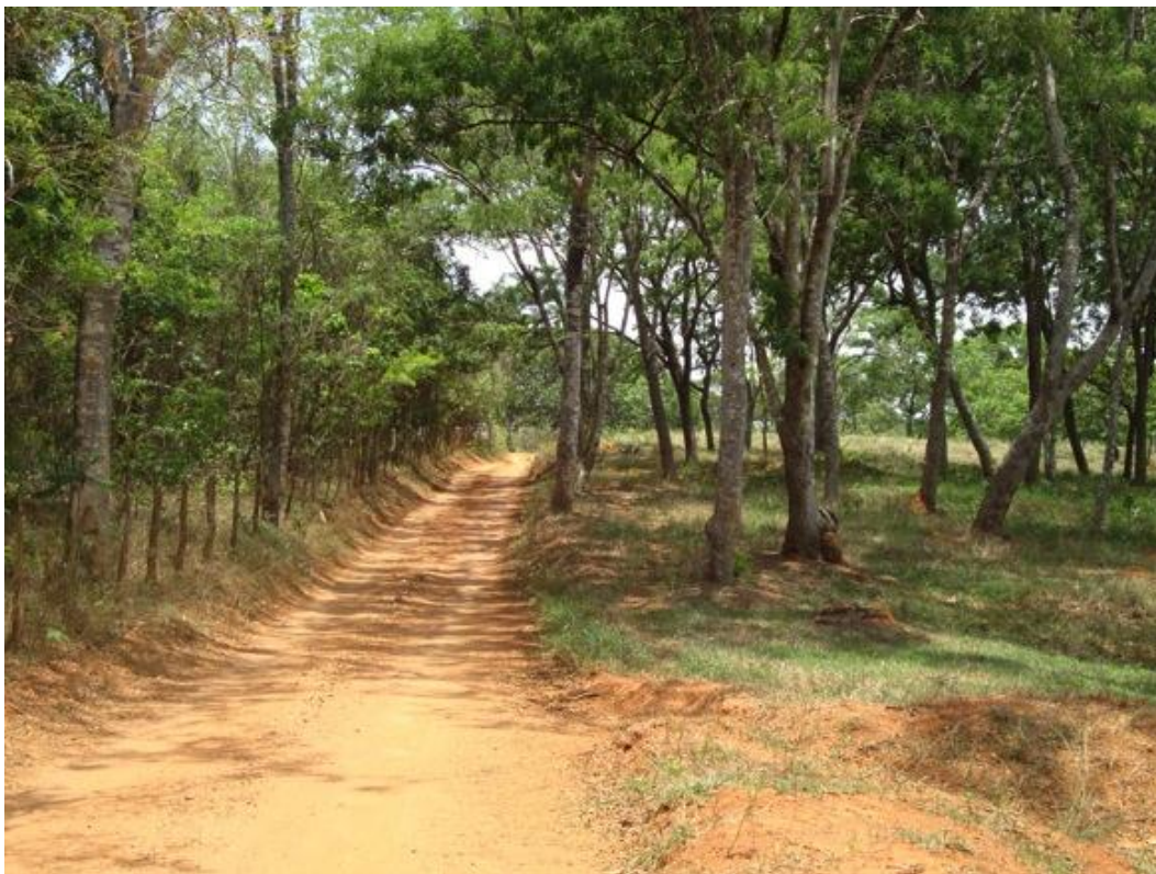
Figura 1: Estrada sem medidas de conservação do solo passando dentro de árvores remanescentes de um "Cerradão".
