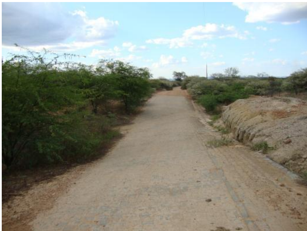
Figura 24 - Exemplo de passagem molhada de pedra no córrego Onça, Afogados da Ingazeira/PE.
