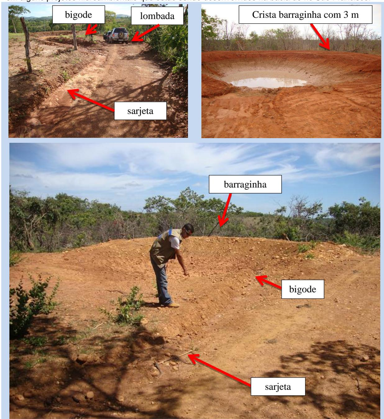
**Figura 7.5 - Dispositivos de drenagem das estradas rurais para as cacimbas.**
