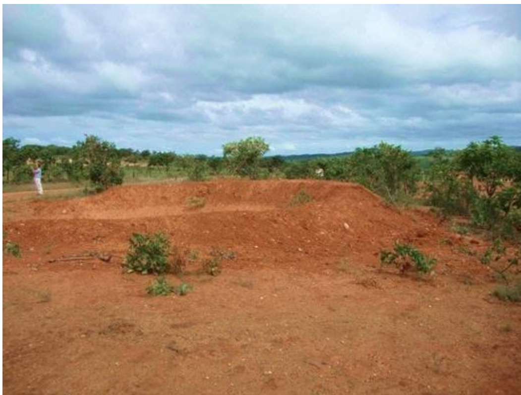
Foto 12: Vista lateral da mesma barragem da foto acima
