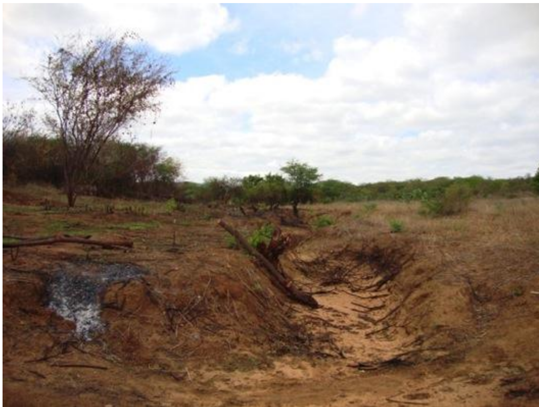
Foto 1: Drenagem na microbacia do Córrego Onça onde serão construídas barragens de pedra sucessivas.
