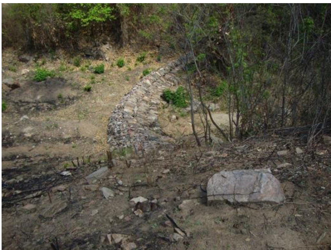
Foto 6: Barragem de pedra com dimensões próximas às requeridas construída no município de Afogados da Ingazeira, PE.
