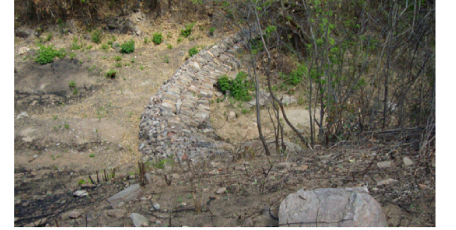
FIGURA 2 - BARRAGEM DE PEDRA SUCESSIVA PARA RETENÇÃO DE SEDIMENTOS
