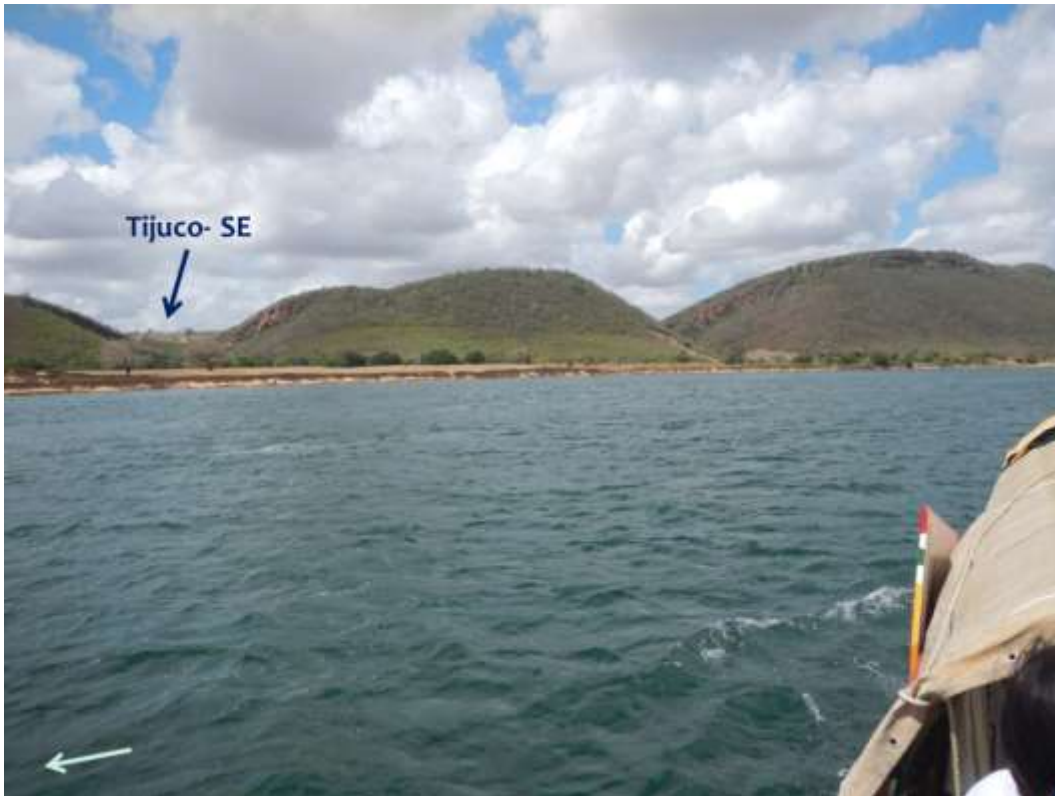
Figura 64 – No través do povoado Tijuco, em SE (cujo porto era acessível por um pequeno canal hoje completamente obstruído), a erosão galopante de antigas croas carrega mais material para o leito do rio
