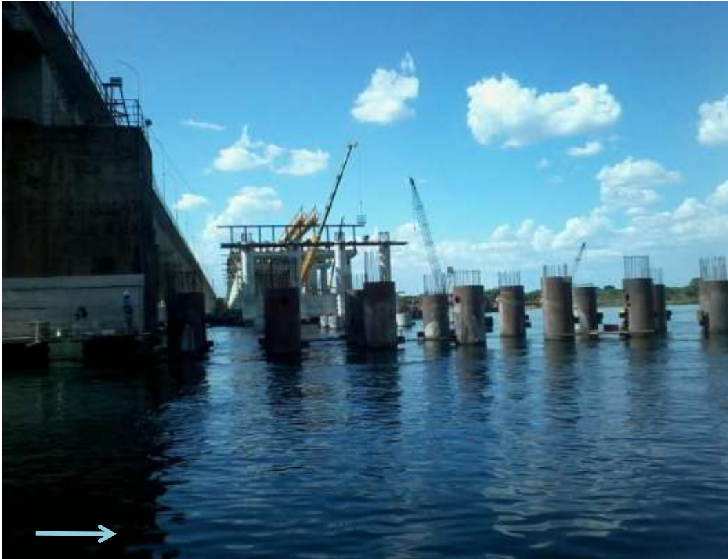
Figura 151 – A replicação de mais um sistema de pilares sem formas hidrodinâmicas junto ao já impactante sistema de pilares da ponte antiga, evidentemente agravará o assoreamento.
