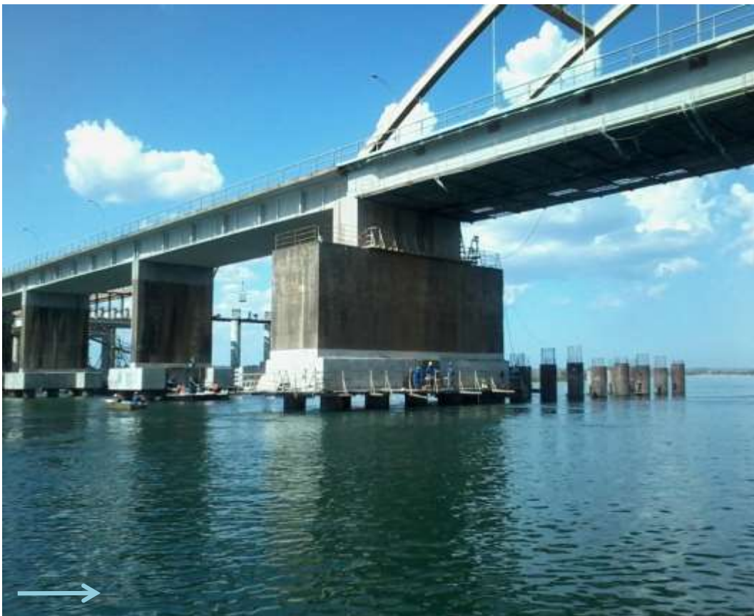
Figura 150 – Agora, em abril, já se constata a instalação das bases dos pilares da segunda ponte.
