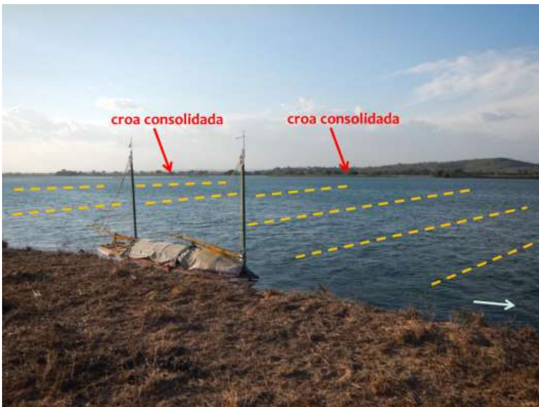
Figura 155B – Este amplo trecho entre a virada na altura da Barra do Itiúba, AL e Propriá, SE, está comprometido pelo assoreamento em toda a sua área.
