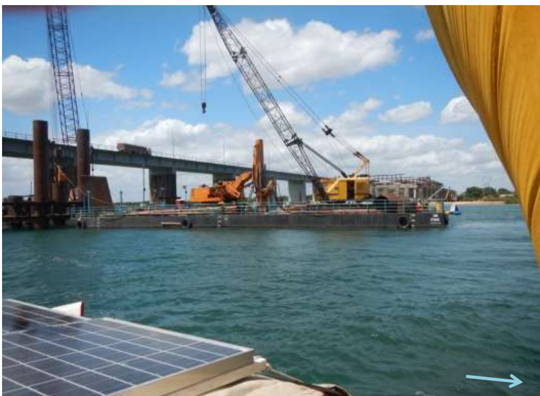
Figura 40 – Da mesma forma, os trabalhos de construção seguem sem qualquer procedimento de agressividade mínima ao rio. O leito agora seco do rio São Francisco é utilizado como um grande canteiro de obras, com máquinas, equipamentos, veículos transitando sem qualquer cuidado.
