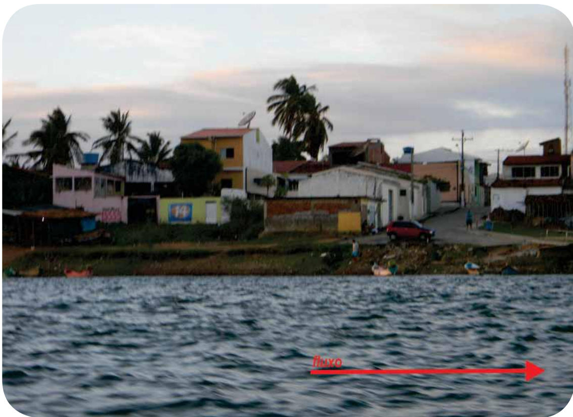
Figura 88 - Em Traipu, a erosão atinge a zona urbana.
