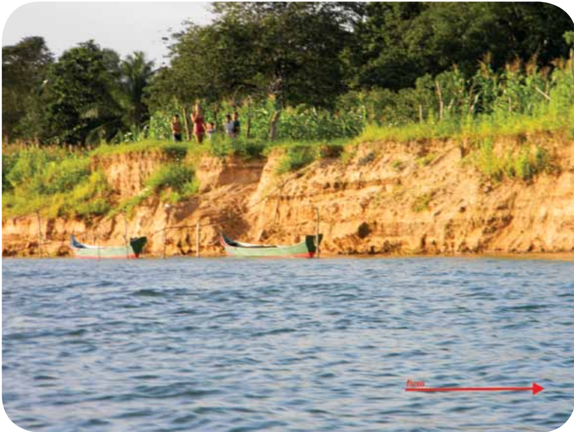
Figura 83 - O povoado Munguengue-AL, a erosão avançou consideravelmente nos últimos anos.
