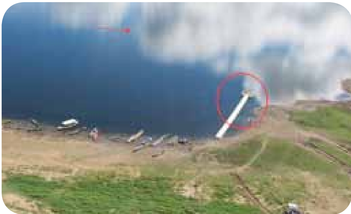
Figura 11 - Captação em Jacaré - Poço Redondo-SE. Fonte: Chesf, 2013
