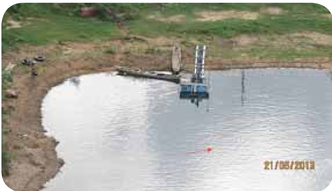
Figura 14 - Ponto de captação do distrito de Santiago. Fonte: Chesf, 2013
