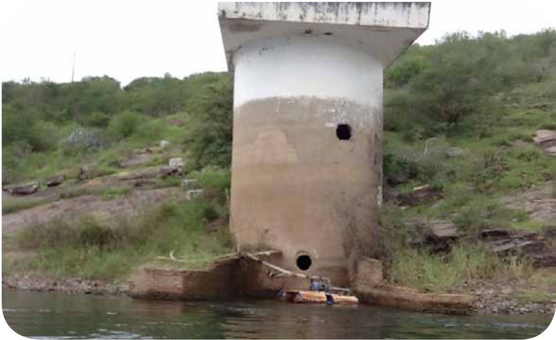
Figura 32 - Ponto de captação de água em Belo Monte-AL
