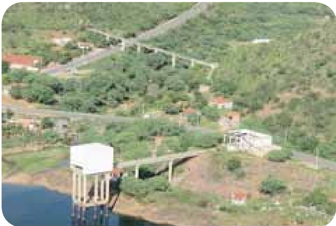
Figura 34 - Canindé do São Francisco - Captação desativada. Fonte: Chesf, 2013
