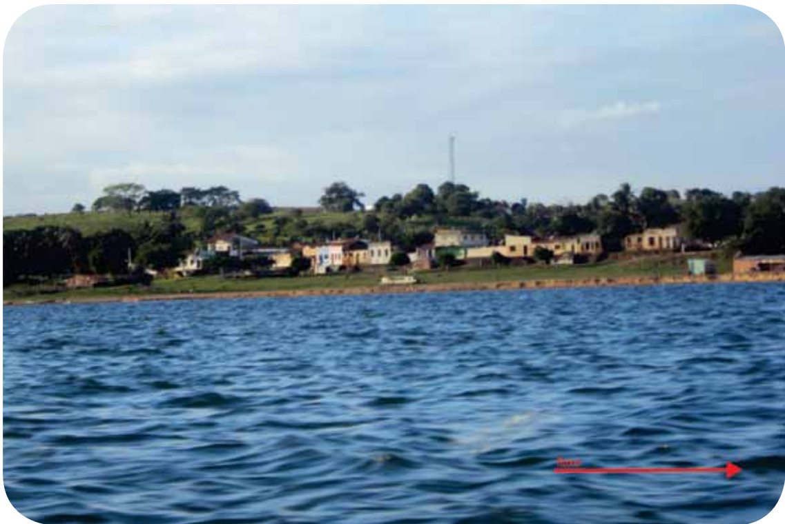
Figura 82 - O povoado Lagoa Comprida-AL, também sofre o descontrole da erosão já próxima do casario.
