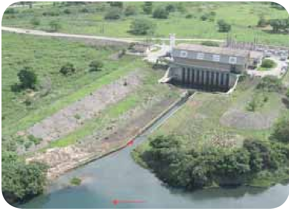
Figura 36 - Canal de captação de Propriá-SE
