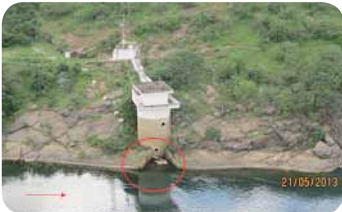
Figura 15 - Ponto de captação de Belo Monte. Fonte: Chesf, 2013
