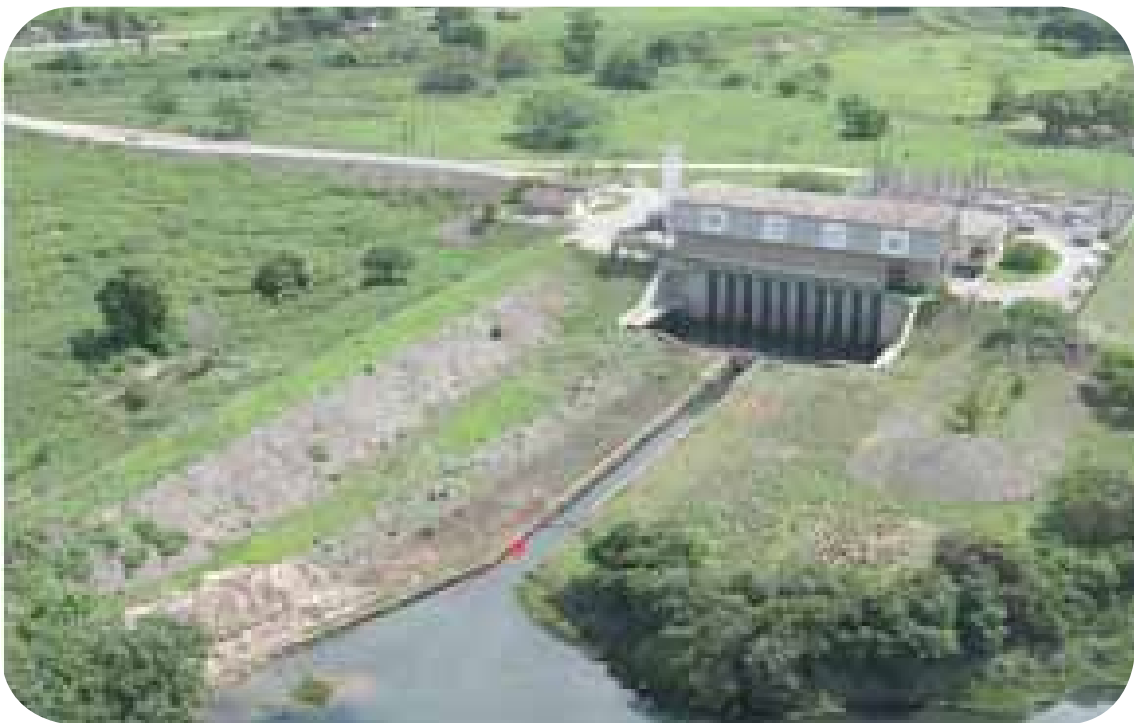
Figura 24 - Canal artificial para a captação de Propriá-SE. Fonte: Chesf, 2013
