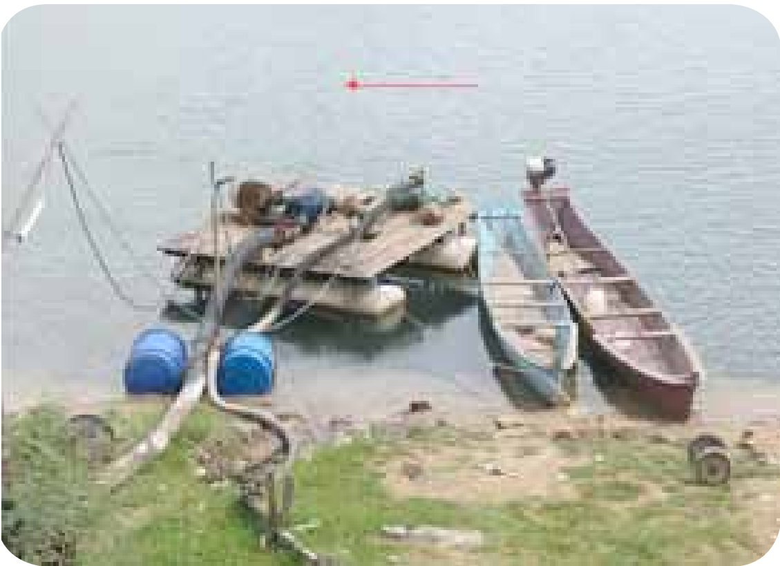
Figura 22 - Captação flutuante de Porto Real-AL. Fonte: Chesf, 2013
