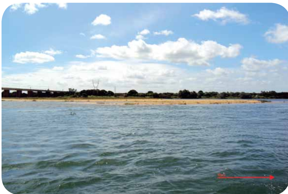
Figura 79 – Bancos de areia a jusante da ponte de Propriá, do eixo do rio em direção à margem alagoana.
