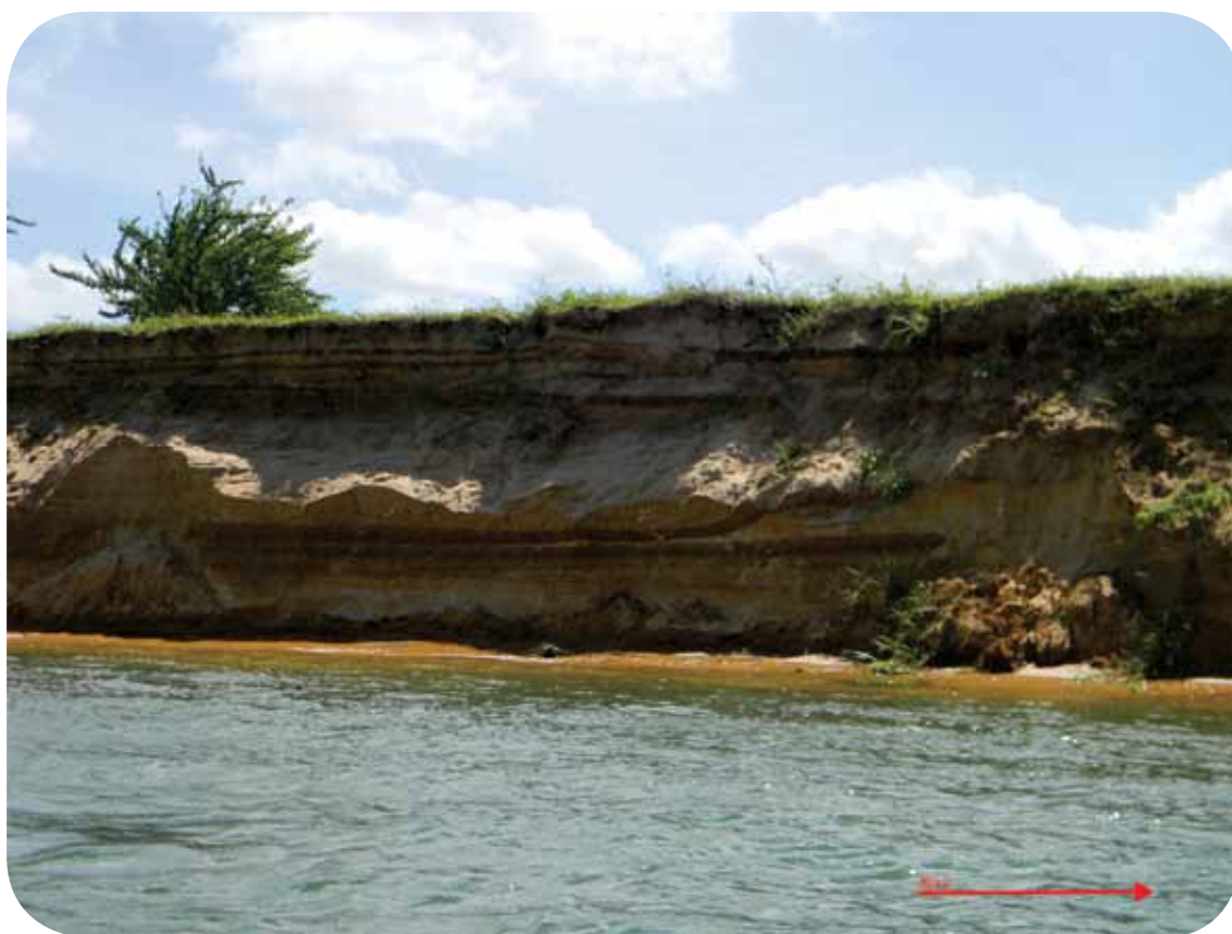
Figura 75 – No Xinaré, uma dos processos erosivos mais violentos no Baixo.
