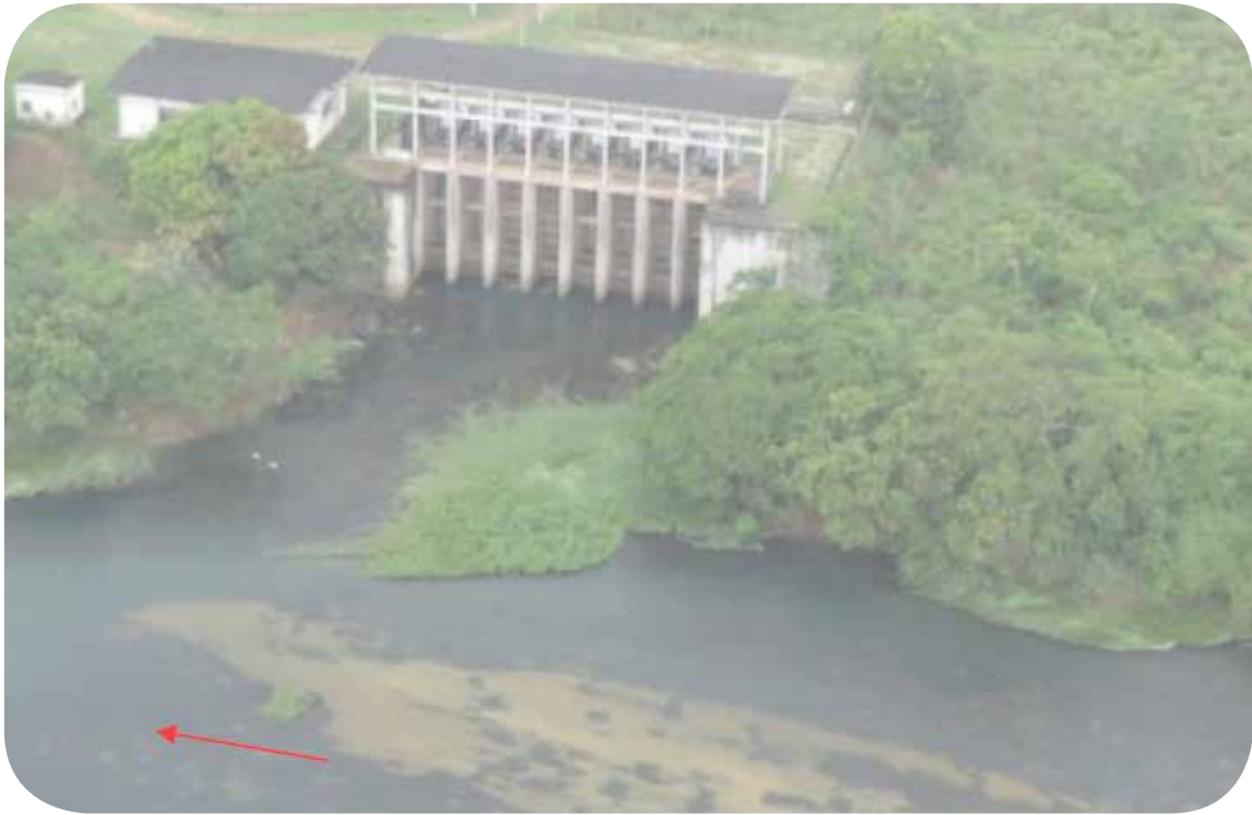
Figura 49 - Vista aérea da captação de água para fins de irrigação no Perímetro Platô de Neópolis, em Sergipe. Fonte: Chesf, 2013.
