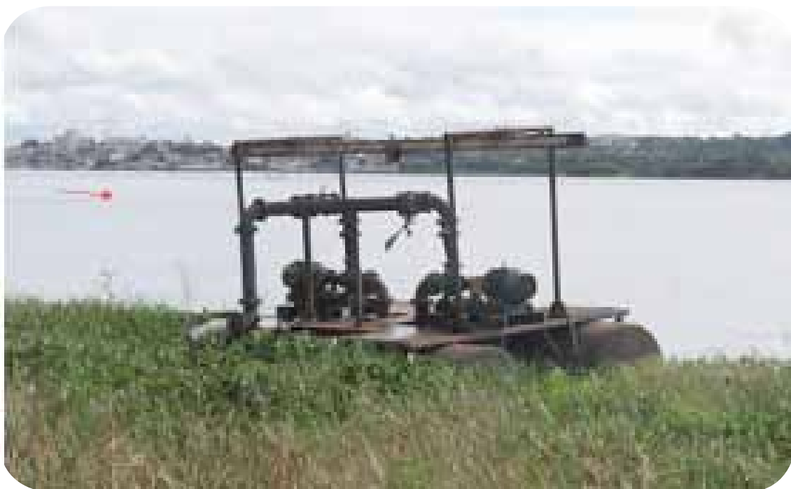
Figura 27 - Captação flutuante do Neopólis. Fonte: Chesf, 2013
