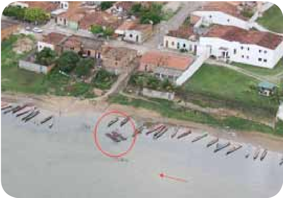
Figura 25 - Captação de água de Saúde (Santana do São Francisco-SE). Fonte: Chesf, 2013
