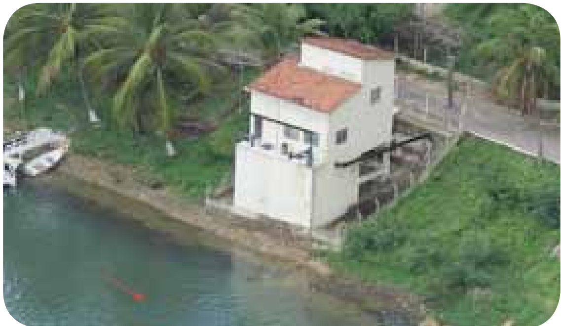
Figura 26 - Captação de água do SAE Penedo-AL. Fonte: Chesf, 2013
