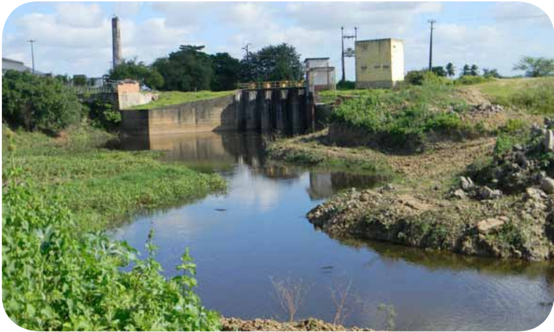
Figura 45 - Vista local da estação de bombeamento do Perímetro Irrigado Propriá, em Sergipe - 10 de julho de 2013.
