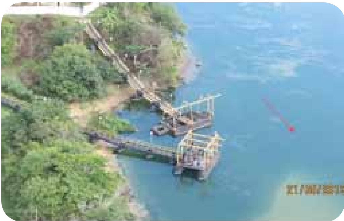
Figura 17 - Captação da DESO, no município de Porto da Folha, em Ilha do Ouro. Fonte: Chesf, 2013
