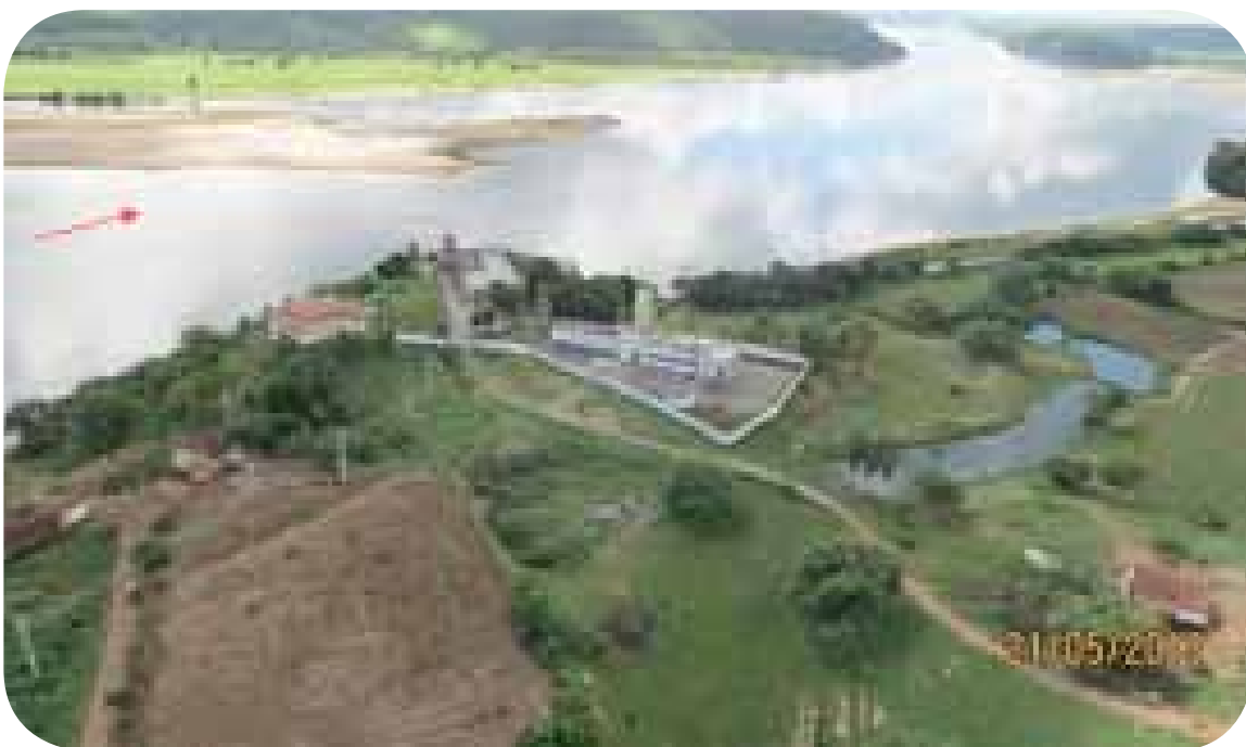
Figura 18 - Panorâmica do sistema de Captação da DESO, em Ilha do Ouro (abastece os municípios de Porto da Folha, Poço Redondo, Monte Alegre e Glória). Fonte: Chesf, 2013
