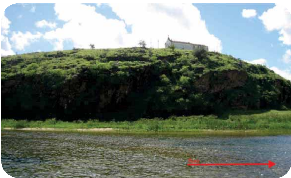
Figura 94 - A foz do rio Ipanema, aos pés da ilha dos Prazeres, obstruída.
