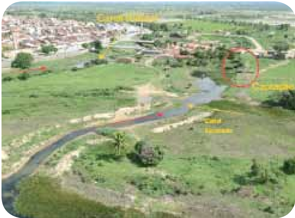
Figura 37 - Situação de assoreamento do canal
