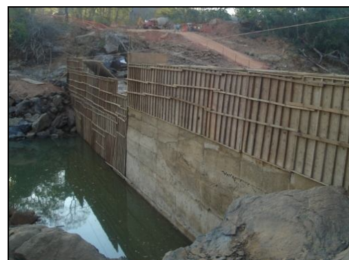
Figura 6: Soleiras vertentes em construção (2007) no trecho a jusante da UHE Amador Aguiar I, rio Araguari – MG. Fotos: Simone Mendes (2007)
