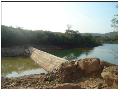
Figura 6: Soleiras vertentes em construção (2007) no trecho a jusante da UHE Amador Aguiar I, rio Araguari – MG. Fotos: Simone Mendes (2007)
