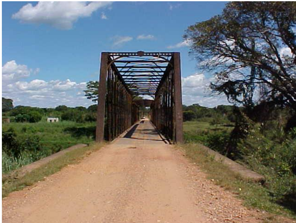
BV152 – Rio das Velhas – LOCALDE COLETA
