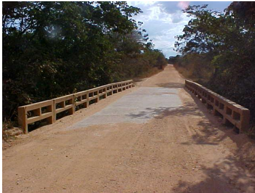
Ponte de Acesso – SC33
