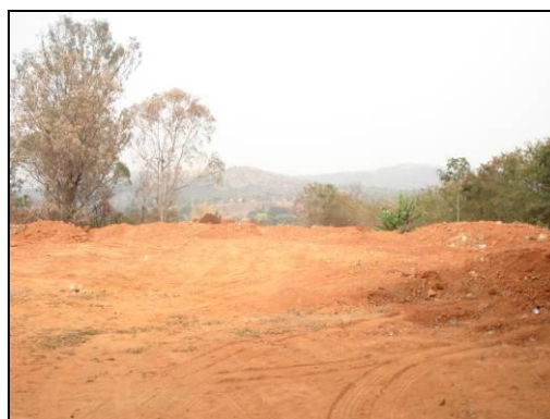
Vala encerrada do aterro.
