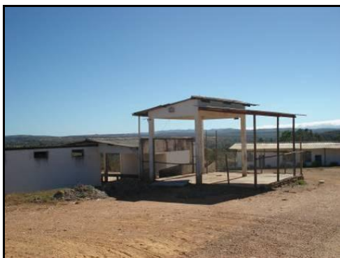
Estrutura de UTC fora de operação.
