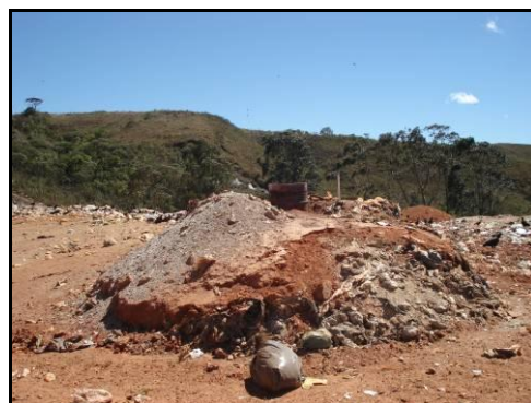
Sistema de captação de gás.
