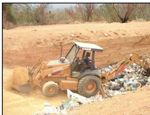
Vala em operação.
