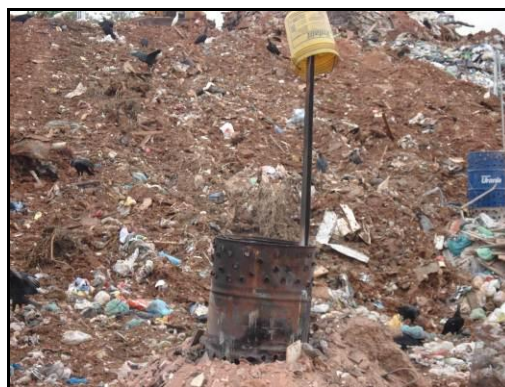
Dreno de gases.
