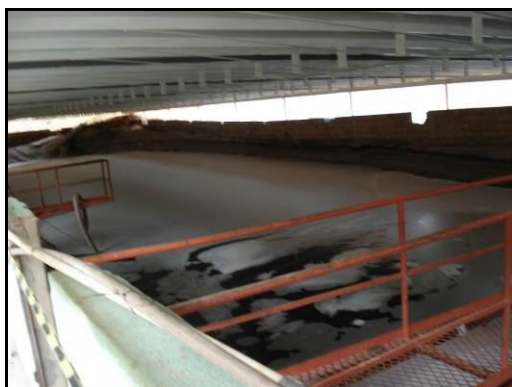
Tanque de armazenamento de lixiviado.
