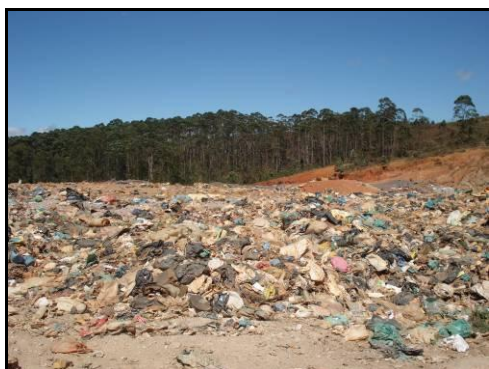
Resíduos sem recobrimento.
