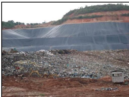
Frente de operação
