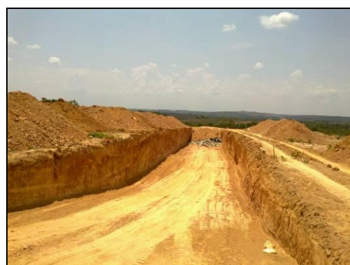
Vala para disposição dos RSU.
