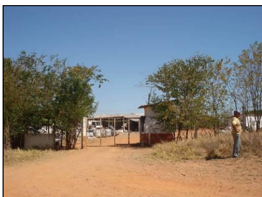
Entrada do depósito.
