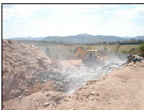
Presença de queima de resíduos.
