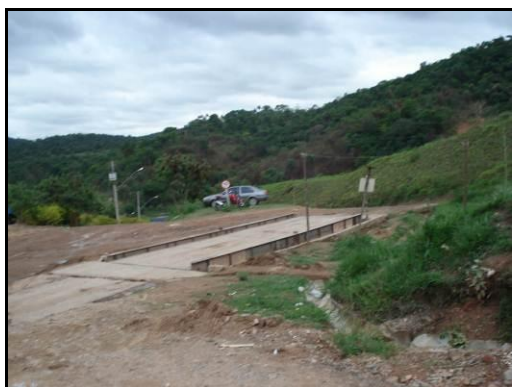
Balança na entrada do aterro.
