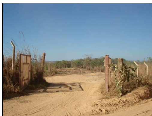
Entrada do aterro.
