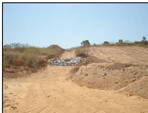
Vala em operação.
