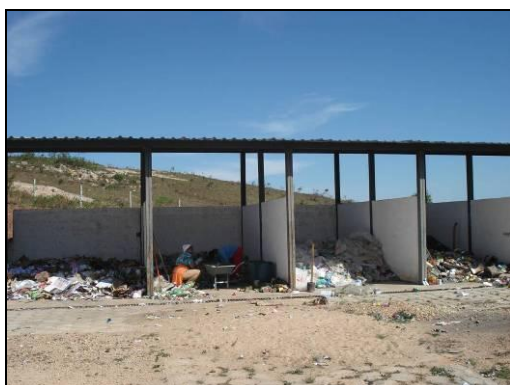
Baías de armazenagem.
