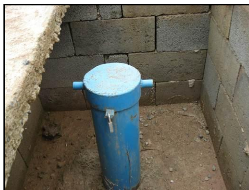
Um dos poços de monitoramento.
