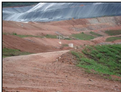
Talude encerrado e parcialmente revegetado.
