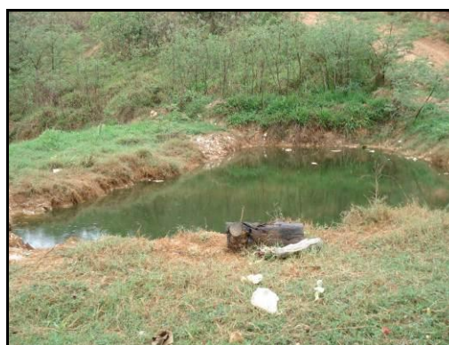
Lagoa de estabilização de chorume.
