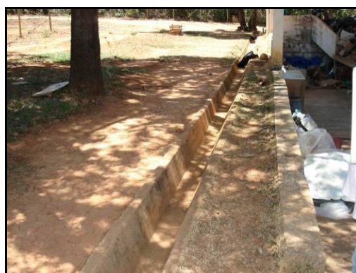
Sistema de drenagem pluvial.
