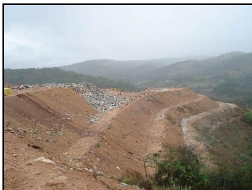
Lixo exposto sem recobrimento.
