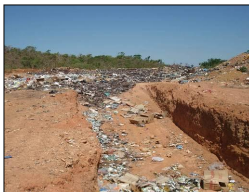
Vala em operação.
