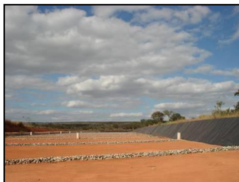
Obras do aterro sanitário em fase final.
