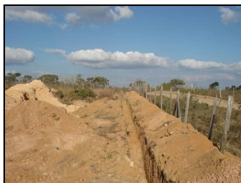
Sistema de drenagem pluvial.
