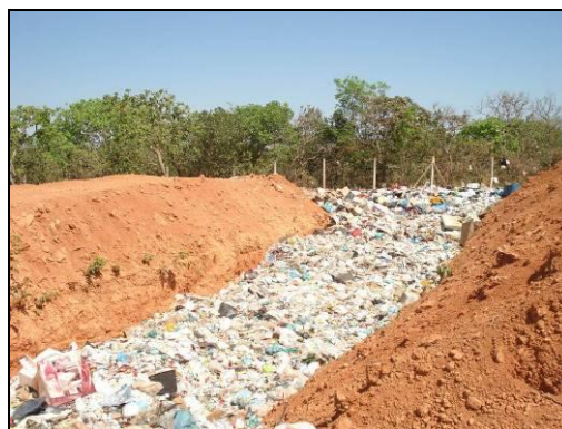
Vala de rejeitos.
