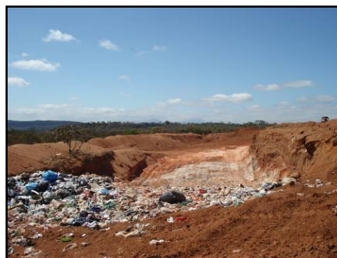
Vala em operação de RSU.
