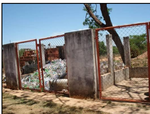
Baias de armazenamento sem cobertura.
