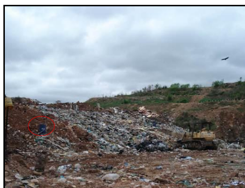
Área de operação. Observa-se dreno de gases.
