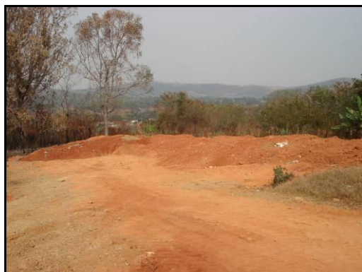
Vala encerrada do aterro.
