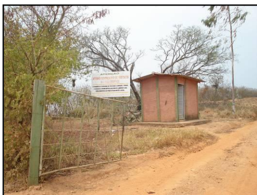
Entrada do depósito.
