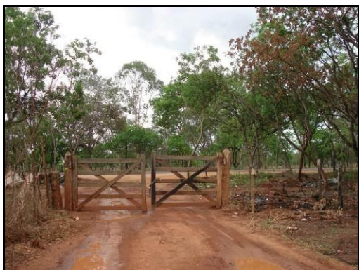
Entrada do depósito.
