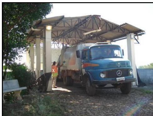
Plataforma de descarregamento de caminhões.
