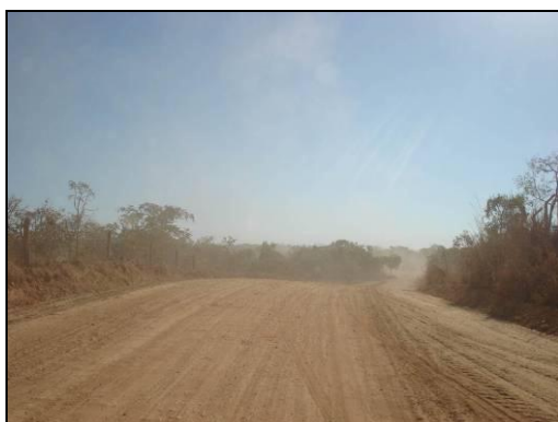
Acesso ao aterro.
