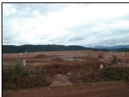
Vista geral do aterro, com presença de urubus.
