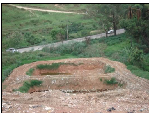
Armazenamento de chorume.
