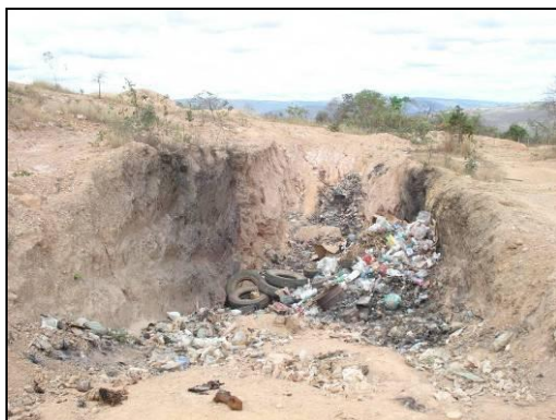
Trincheira em operação.
