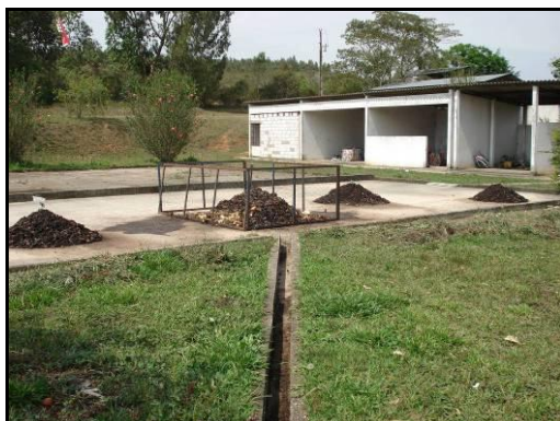
Pátio de compostagem e área das baias.
