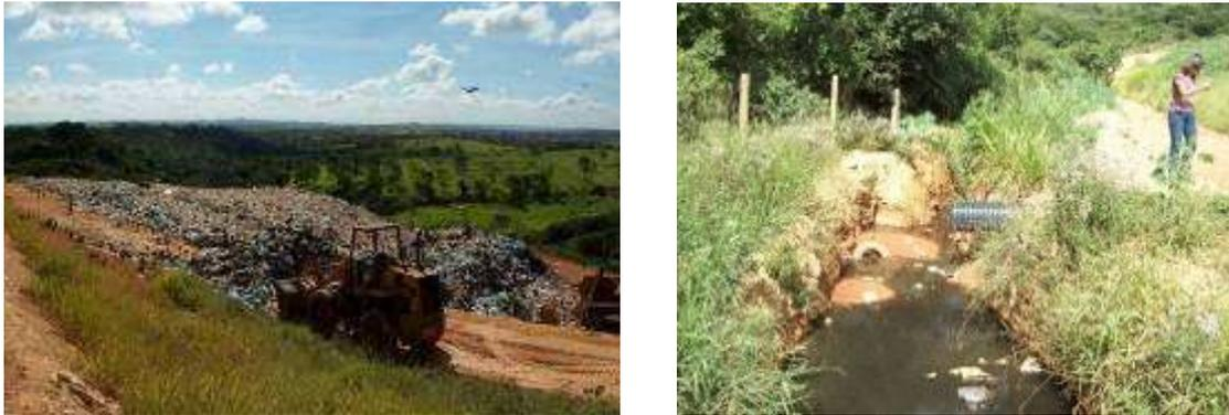
Figura 14 – Vista da frente da operação do depósito de resíduos (esquerda) e vala utilizada para acumulação de percolados, apresentando condições precárias (direita), do empreendimento de resíduos de Sete Lagoas
