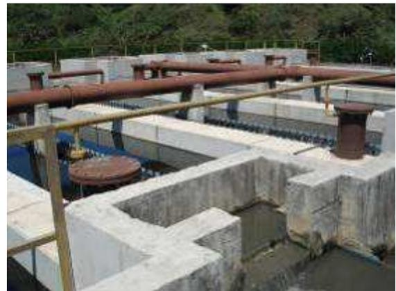
Figura 193 – Tratamento preliminar (esquerda) e reator UASB (direita) da ETE Nova Pampulha
