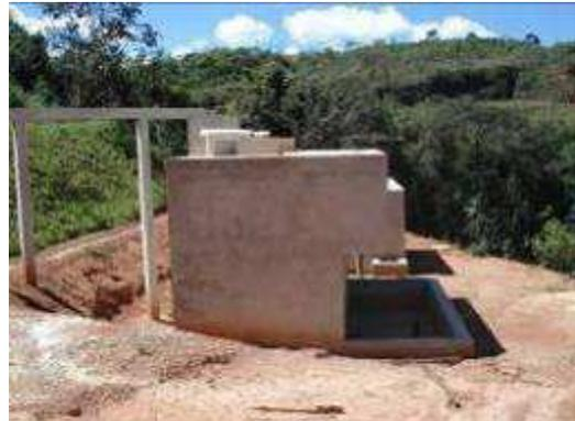
Figura 61 – Tratamento preliminar (esquerda) e reator UASB (direita) da ETE Santa Frutuosa
