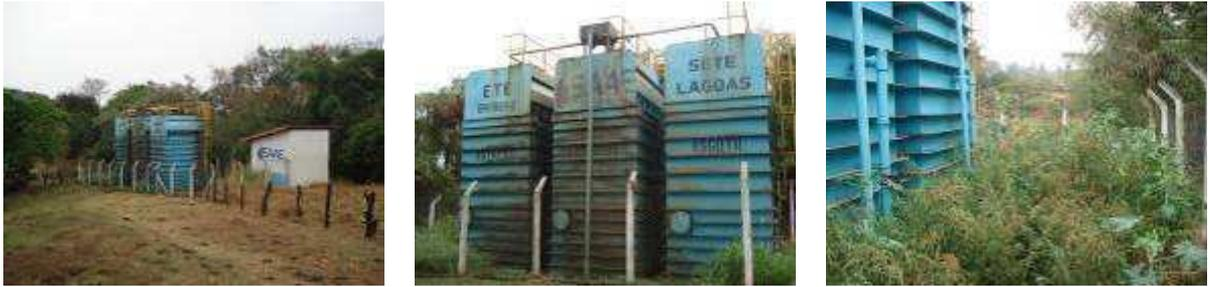
Figura 173 – Sistema de tratamento em condições precárias da ETE Barreiro
