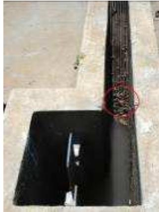
Figura 154 – Gradeamento obstruído e indicação da área da grade onde está depositado o material
