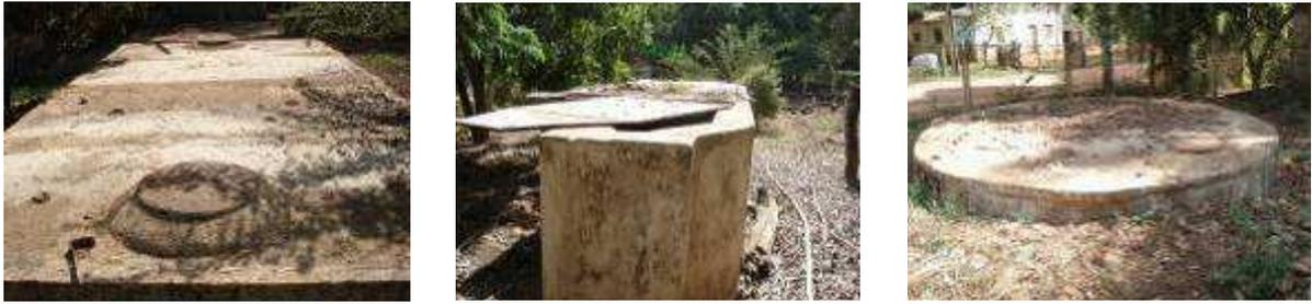
Figura 36 – Tratamento preliminar (esquerda), tanque séptico (central) e filtro anaeróbio (direita) da ETE Araçaí
