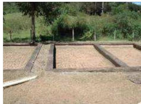
Figura 59 – Vista superior do filtro anaeróbio (esquerda) e leito de secagem (direita) da ETE São Geraldo
