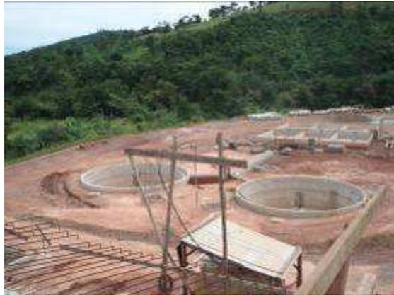
Figura 90 – Vista superior dos decantadores e leitos de secagem
