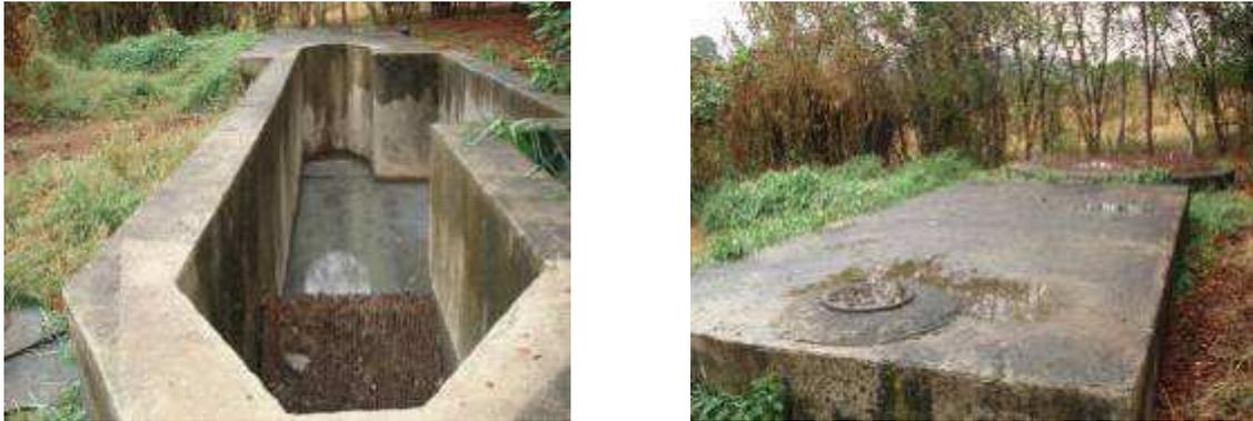
Figura 184 – Tratamento Preliminar (esquerda) e tanque séptico seguido de filtro anaeróbio (direita) da ETE Iporanga
