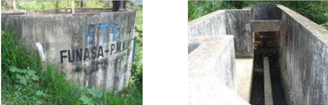
Figura 125 – Filtro anaeróbio (esquerda) e tratamento preliminar (direita) da ETE Nova Aparecida de Nova União
