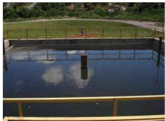
Figura 194 – Filtro biológico percolador (esquerda) e decantador (direita) da ETE Nova Pampulha
