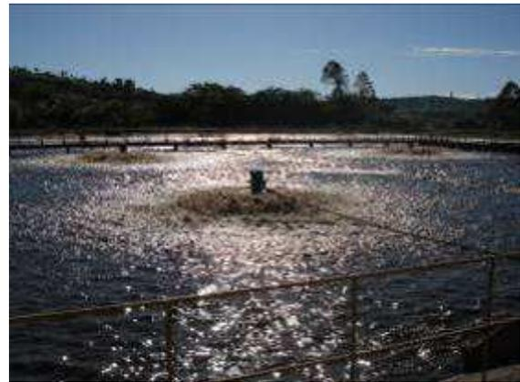
Figura 190 – Desarenador do tratamento preliminar (esquerda) e lagoas aeradas (direita) da ETE Vespasiano SEDE
