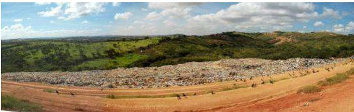
Figura 15 – Grande quantidade de resíduos expostos e urubus na plataforma em operação
