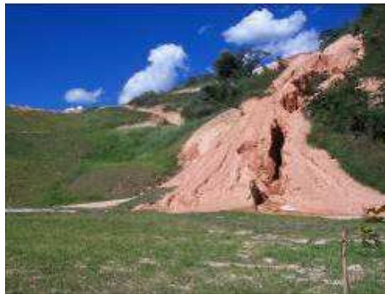
Figura 13 – Pontos de erosão próximos ao dique de sustentação do aterro sanitário
