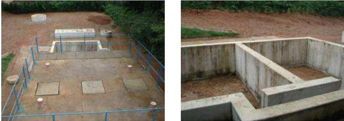
Figura 86 – Filtro anaeróbio (esquerda) e leito de secagem (direita) da ETE Chiqueiro
