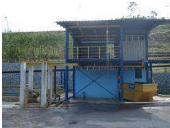
Figura 111 – Central para centrifugação do lodo gerado no tratamento da ETE Vale do Sereno
