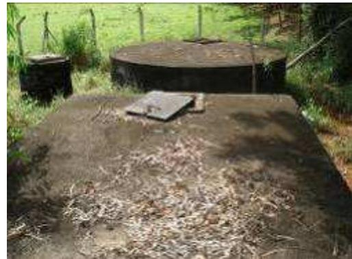
Figura 106 – Tratamento preliminar (esquerda) e tanque séptico seguido de filtro anaeróbio (direita) da ETE Monjolos
