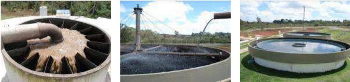
Figura 113 – Detalhe do distribuidor de vazão do reator UASB (esquerda), filtro biológico percolador (central) e decantador secundário (direita) da ETE Jardim Canadá
