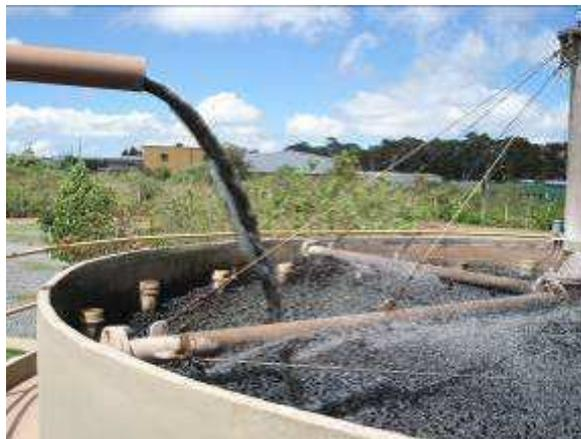
Figura 114 – Efluente do reator UASB sendo lançado no filtro biológico percolador
