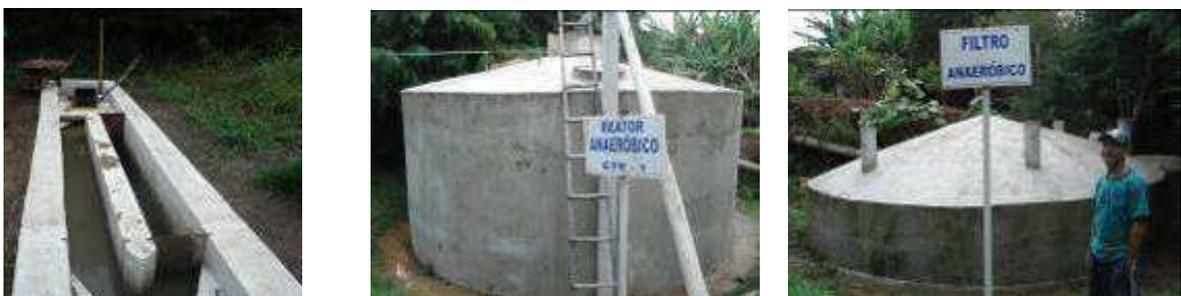
Figura 131 – Tratamento preliminar (esquerda), reator UASB (central) e filtro anaeróbico (direita) da ETE Presidente Kubitschek
