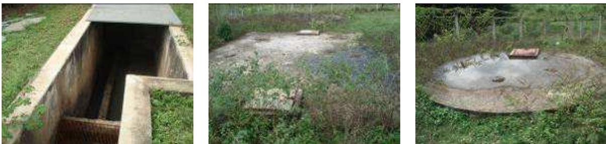
Figura 164 – Tratamento preliminar (esquerda), tanque séptico (central) e filtro anaeróbio (direita) da ETE Ribeirão Jequitibá
