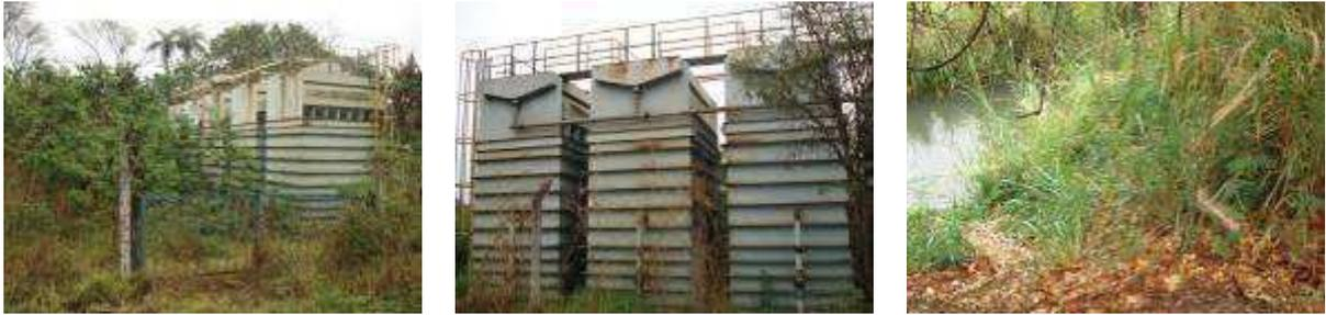
Figura 135 – Reator UASB em estado precário (esquerda), detalhe do reator UASB (central) e lançamento do efluente da ETE Prudente de Morais no curso d’água receptor (direita)
