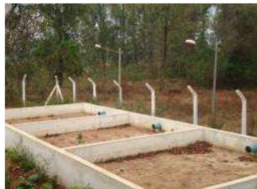
Figura 179 – Reator UASB (esquerda) e leito de secagem (direita) da ETE Areias
