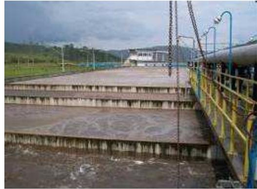
Figura 46 – Vista geral dos reatores de lodos ativados (esquerda) e vista da entrada do efluente no reator (direita) da ETE Arrudas
