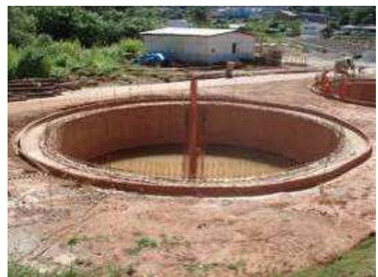
Figura 56 – Filtro biológico percolador (esquerda) e decantador (direita) da ETE Principal
