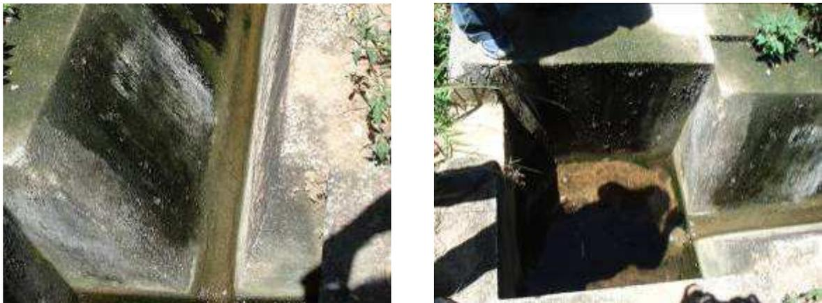
Figura 153 – Canaleta para coleta do efluente da disposição no solo da ETE APAC
