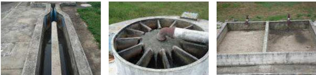
Figura 159 – Tratamento preliminar (esquerda), reator UASB (central) e leito de secagem (direita) da ETE Bom Destino Norte
