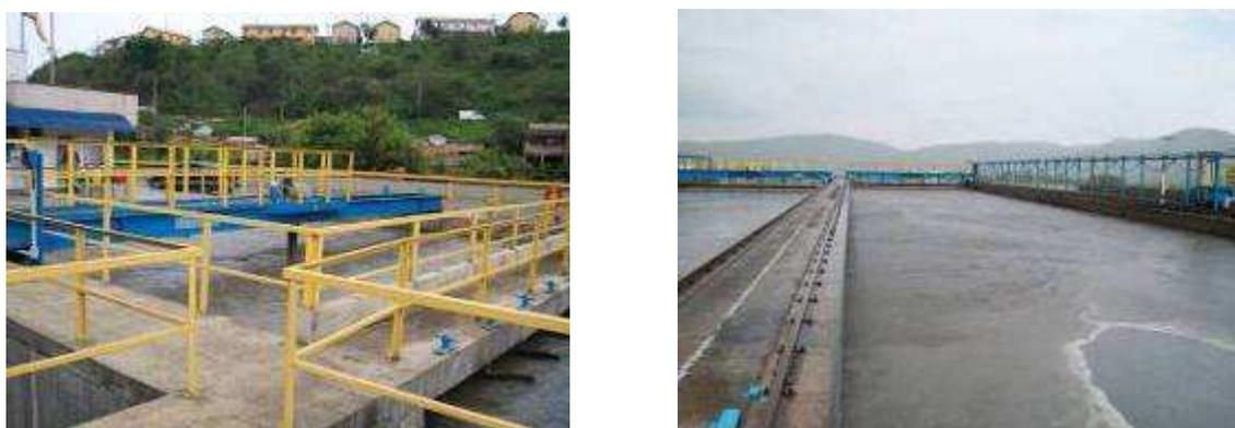
Figura 45 – Desarenador do tratamento preliminar (esquerda) e decantadores primários (direita) da ETE Arrudas
