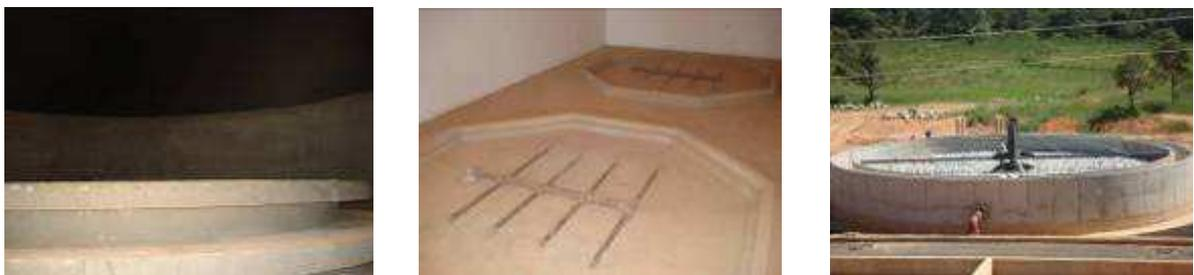
Figura 78 – Detalhe do aerador em cascata (esquerda), dos distribuidores de gases residuais (central) e filtro biológico percolador (direita)
