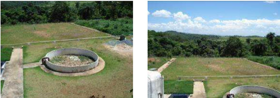
Figura 151 – Leito de secagem (esquerda) e disposição no solo por escoamento superficial (direita) da ETE APAC
