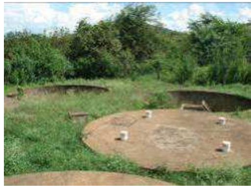
Figura 108 – Tratamento preliminar (esquerda) e filtros anaeróbios e ao fundo leitos de secagem (direita) da ETE Morro da Garça
