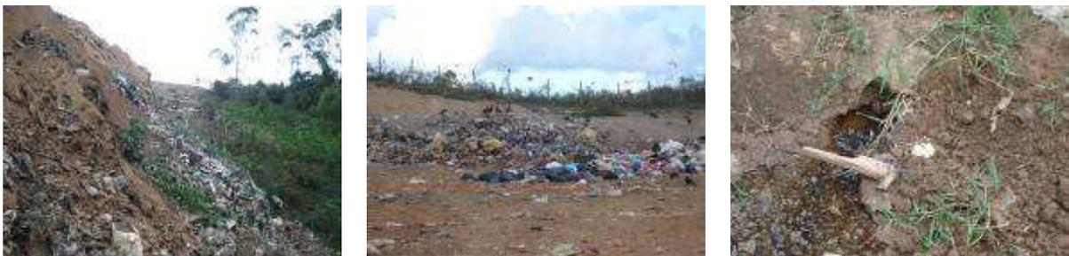
Figura 9 – Plataforma de resíduos com declividade elevada e sem o recobrimento adequado de resíduos (esquerda), grande quantidade de resíduos expostos e presença de urubus (central) e infiltração de chorume no solo (direita)
