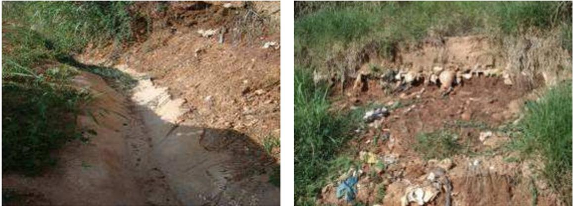
Figura 11 – Canaletas de concreto (esquerda) e carência de impermeabilização (direita) do aterro controlado de Sabará
