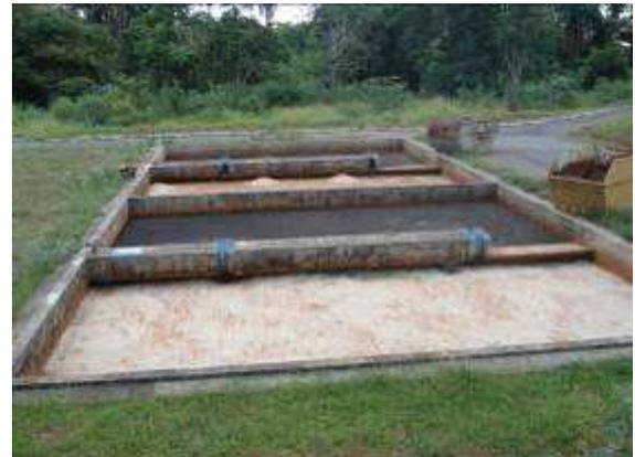
Figura 102 – Tanques de floculação e flotação (esquerda) e leitos de secagem (direita) da ETE Vila Maria
