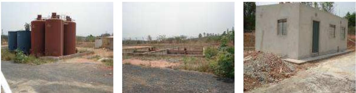
Figura 143 – Sistema de Tratamento (esquerda), leitos de secagem (central) e casa de apoio (direita) da ETE José Martinho Drumond
