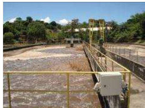
Figura 197 – Tratamento preliminar (esquerda) e lagoas aeradas (direita) da ETE Morro Alto
