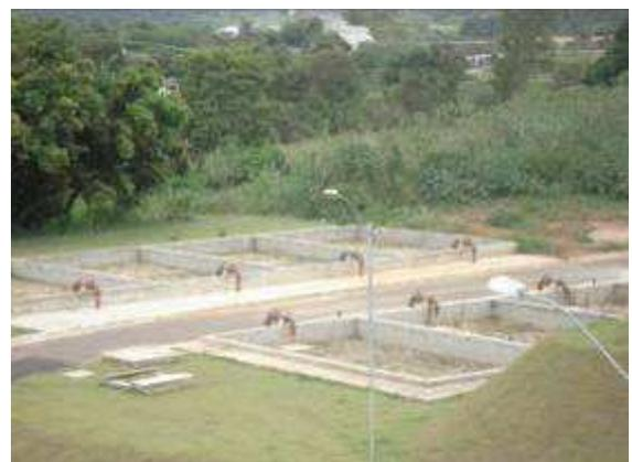
Figura 170 – Queima do gás proveniente do reator UASB (esquerda) e leito de secagem (direita) da ETE São José da Lapa
