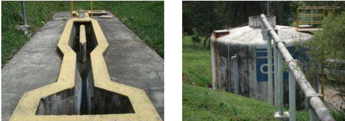
Figura 161 – Tratamento preliminar (esquerda) e reator UASB (direita) da ETE Bom Destino Sul
