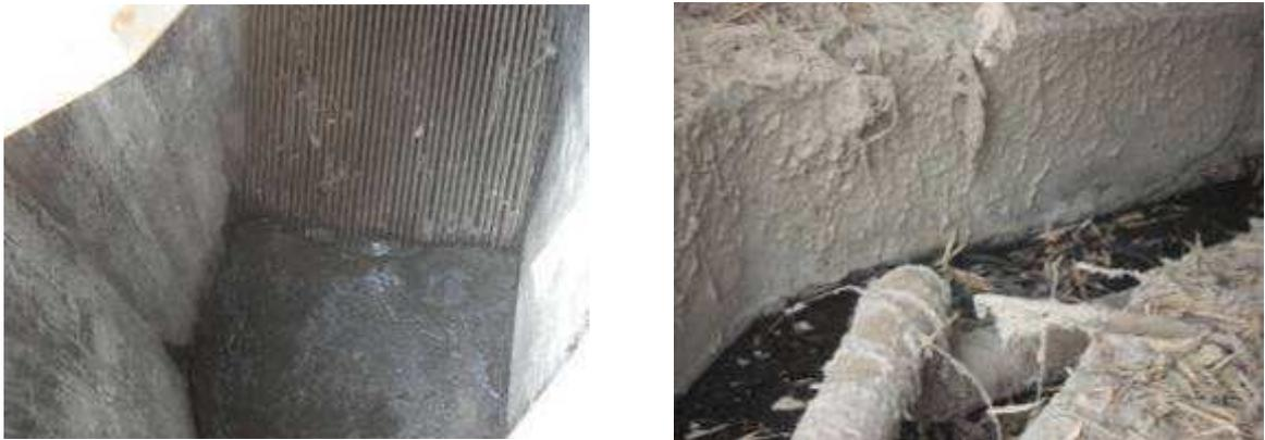
Figura 37 – Grade do tratamento preliminar (esquerda) e efluente do tratamento preliminar da ETE de Araçaí
