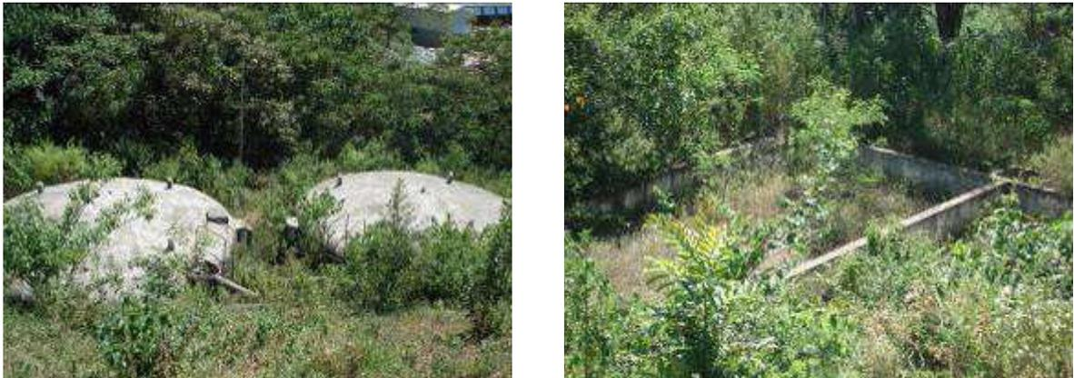
Figura 149 – Reatores (esquerda) e leitos de secagem (direita) de uma ETE de Sabará em más condições de conservação
