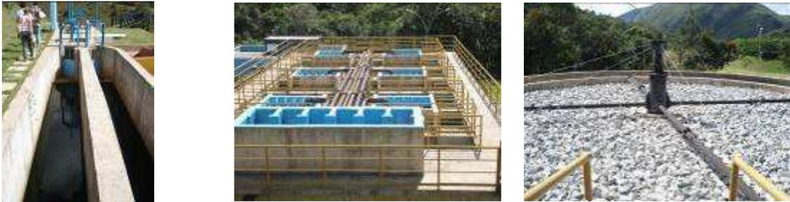
Figura 110 – Tratamento preliminar (esquerda), reator UASB (central) e filtro biológico percolador (direita) da ETE Vale do Sereno
