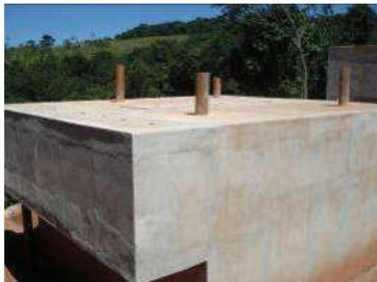
Figura 62 – Filtro anaeróbico, ainda inacabado da ETE Santa Frutuosa
