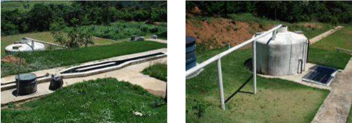
Figura 150 – Tratamento preliminar (esquerda) e reator UASB (direita) da ETE APAC
