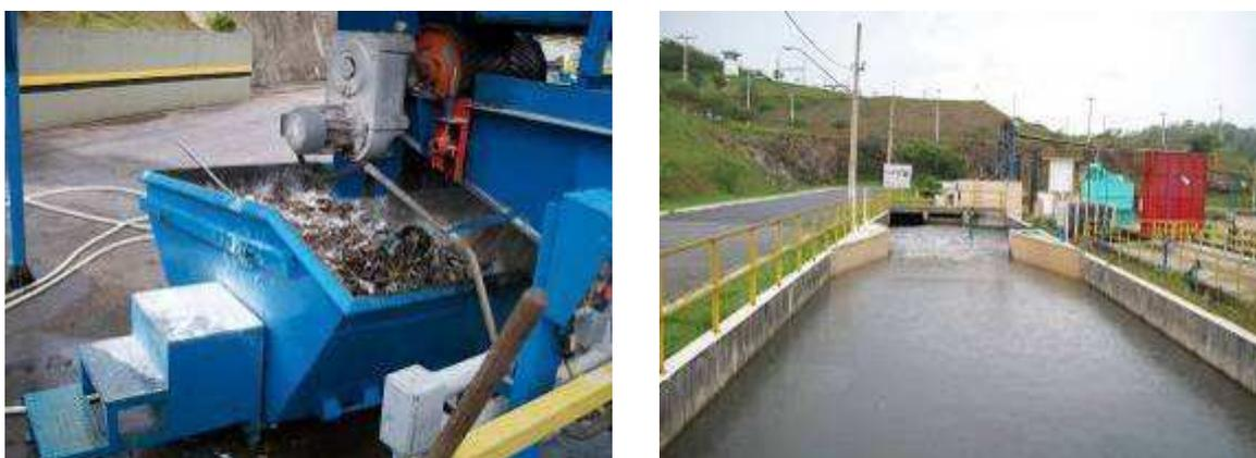
Figura 44 – Caçamba de armazenamento do material retido no gradeamento (esquerda) e calha Parshall (direita) da ETE Arrudas
