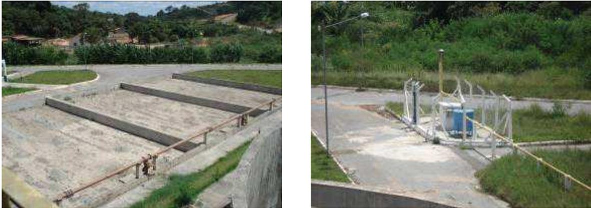
Figura 195 – Leito de secagem (esquerda) e queimador de biogás (direita) da ETE Nova Pampulha
