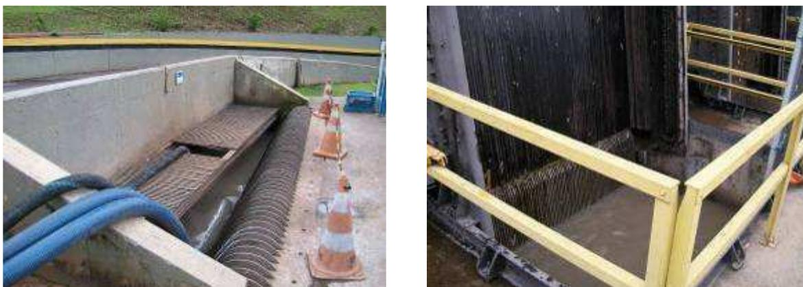
Figura 43 – Grades grossa (esquerda) e fina mecanizada (direita) do tratamento preliminar da ETE Arrudas
