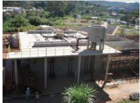
Figura 55 – Tratamento preliminar (esquerda) e reator UASB (direita) da ETE Principal
