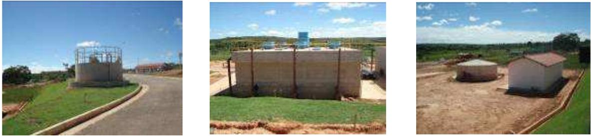
Figura 77 – Caixa de passagem e casa de apoio (ao fundo) (esquerda), reator UASB (central) e aerador em cascata à esquerda e desodorizador à direita (direita)
