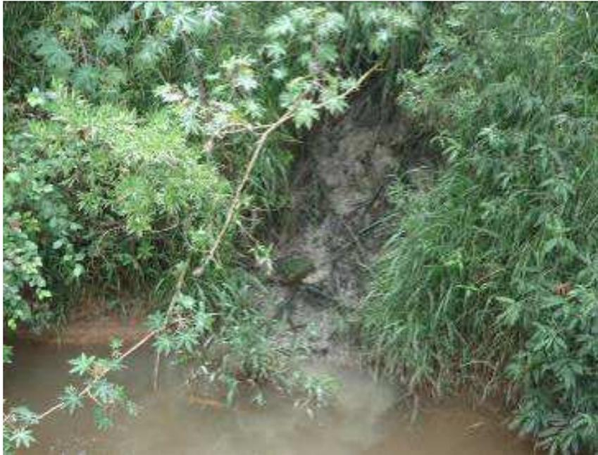
Figura 88 – Lançamento do efluente da ETE Chiqueiro, sem tratamento
