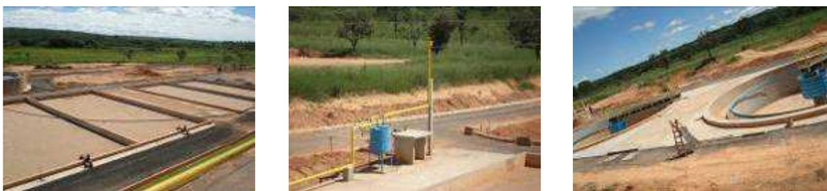
Figura 79 – Unidades de leitos de secagem (esquerda), queimadores de biogás (central) e decantadores secundários (direita)
