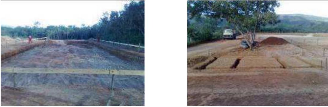
Figura 53 – Implantação da lagoa facultativa (esquerda) e do reator UASB (direita) da ETE de Buenópolis
