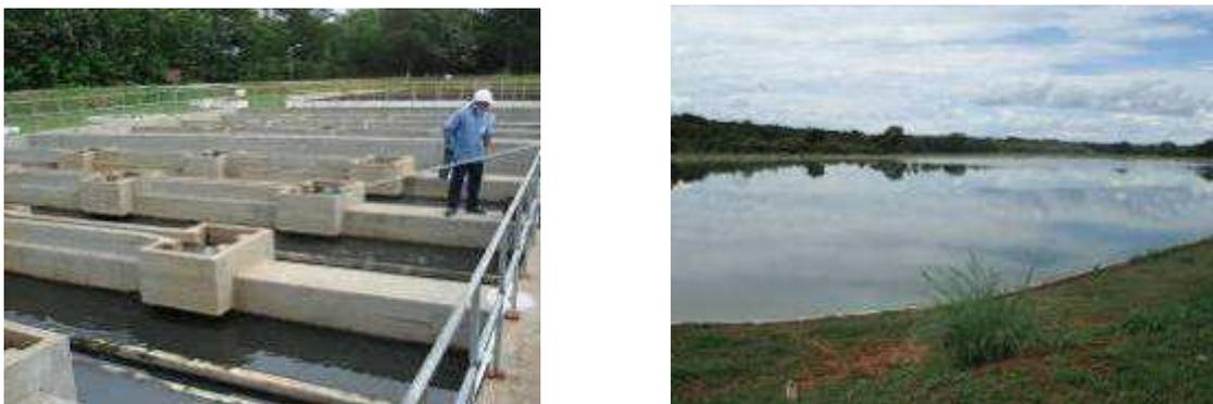
Figura 74 – Detalhe do reator UASB apresentando problemas de vazamento de biogás (esquerda) e vista da lagoa facultativa (direita)
