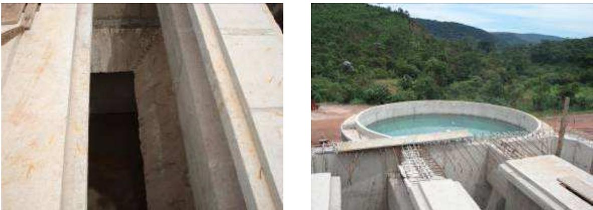
Figura 89 – Detalhe da coifa do reator UASB (esquerda) e vista ao fundo do filtro biológico percolador (direita) da ETE Marzagão
