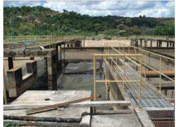
Figura 98 – Tratamento preliminar (esquerda) e câmaras de lodos ativados (direita) da ETE Lagoa Santa
