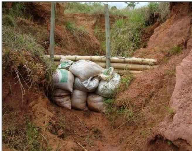
Figura 7 - Uso de paliçadas de bambus e sacos de areia para recuperação de voçorocas
