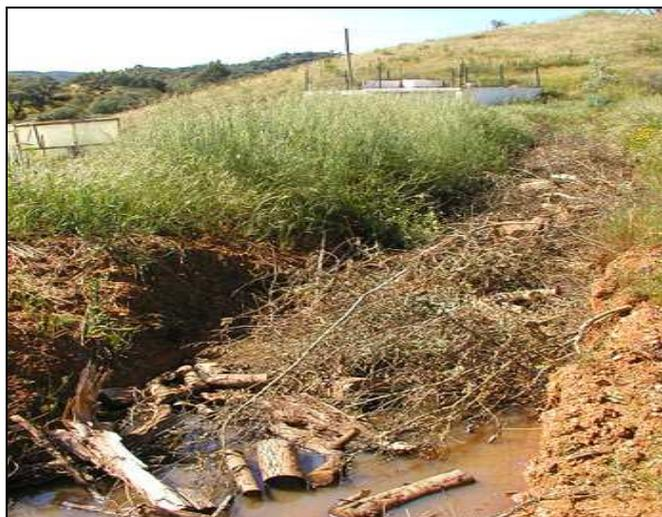
Figura 9 - Uso de *mulch* orgânico em trincheira para contenção da erosão em sulcos
