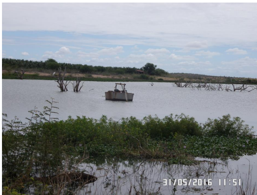
Figura 6.4 – Detalhe da captação de água da Aldeia Tuxá, em Rodelas-BA
