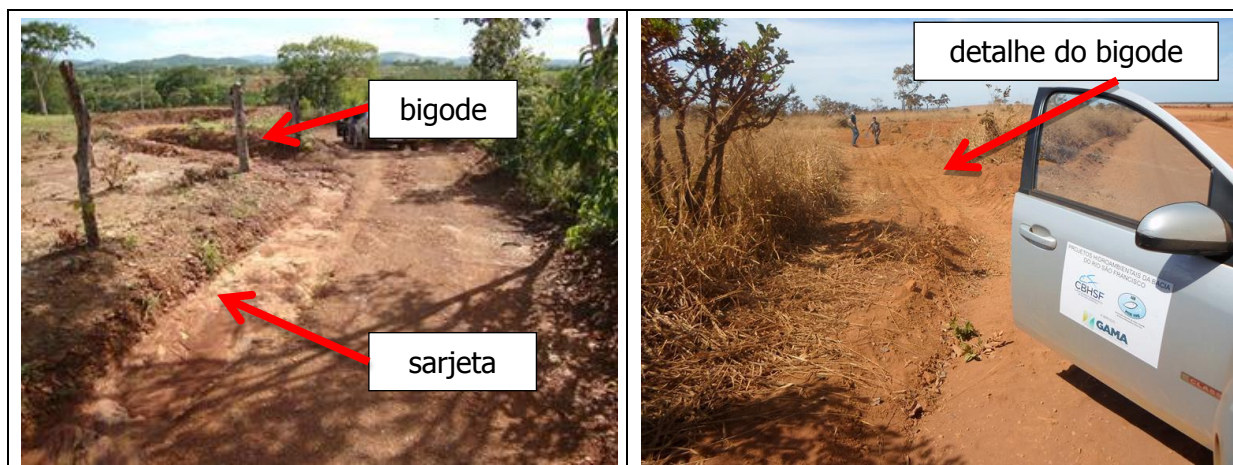
Figura 4.15 – Dispositivos de adequação de estradas rurais.
