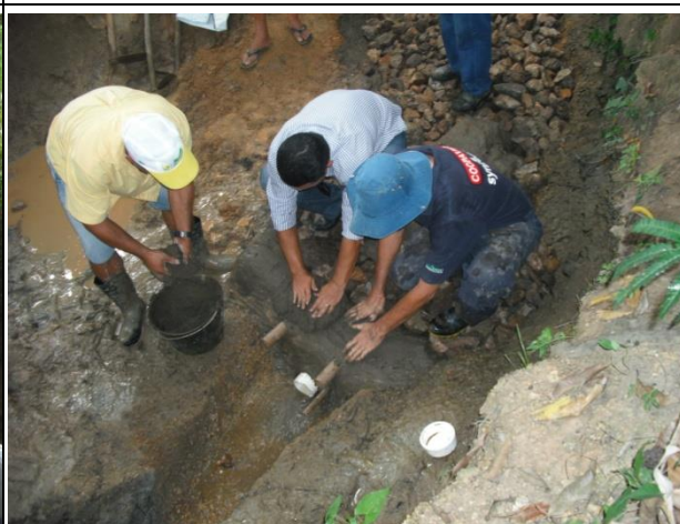
Figura 4.14 – Assentamento dos tubos.
