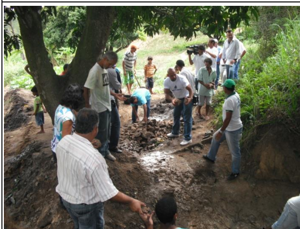
Figura 4.13 – Colocação das pedras.
