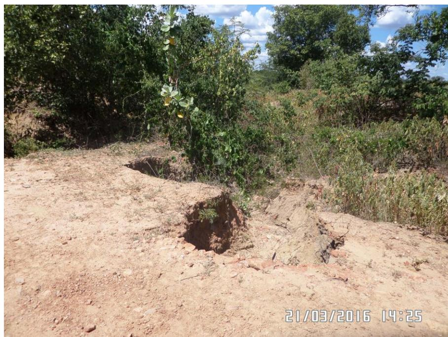
**Figura 6.5 – Foco de erosão na estrada de acesso à Comunidade Barreiro Grande, em Serra do Ramalho-BA**
