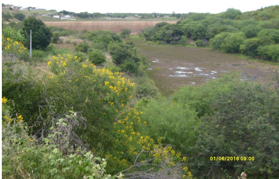
Figura 3.2 – Barragem do Jazigo, em Serra Talhada-PE
