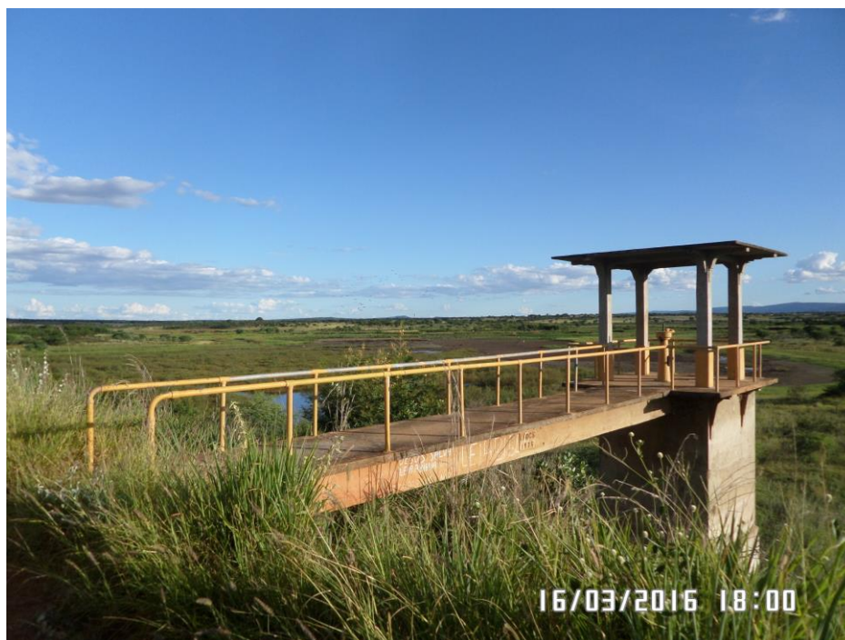
Figura 6.2 – Vista geral do Açude de Macaúbas
